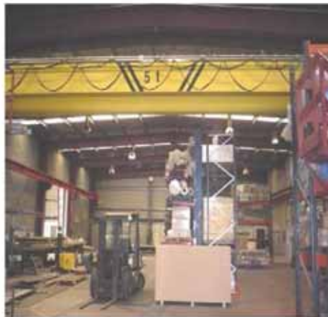
Estanterías de almacenamiento en zona de influencia de puentes-grúa
