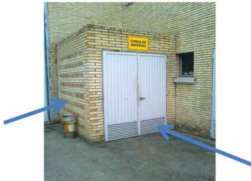
Los locales de baterías dispondrán de dos entradas de aire
