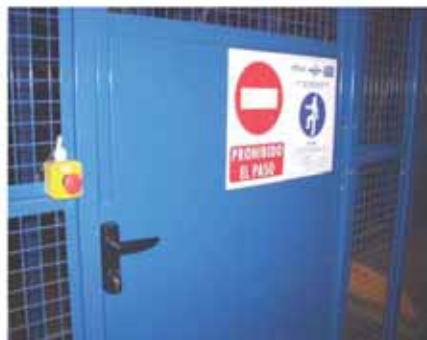
Puerta de acceso a un transelevador
