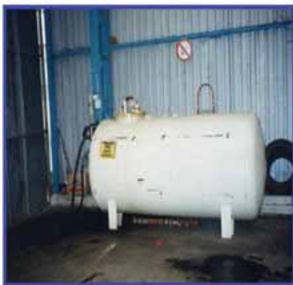
Depósitos sin protección contra golpes en zonas de circulación
