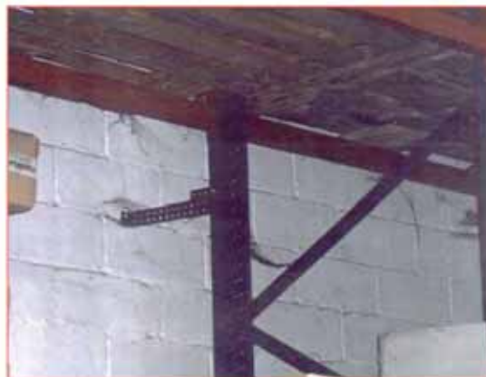
Arriostamiento de la estantería a pared
