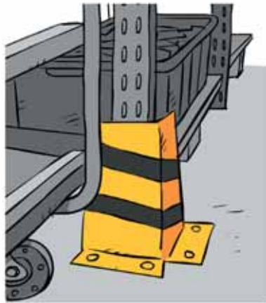
Protección de puntales con colores de seguridad
