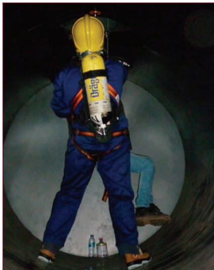
Utilización de equipos de respiración autónoma en espacios confinados
