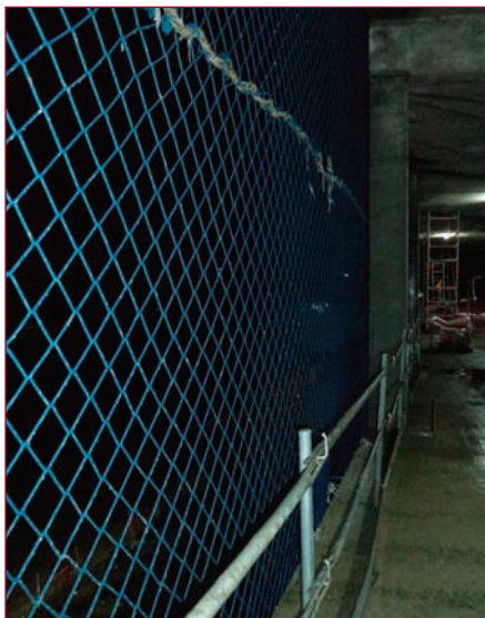
Barandilla perimetral complementada con red vertical de fachada
