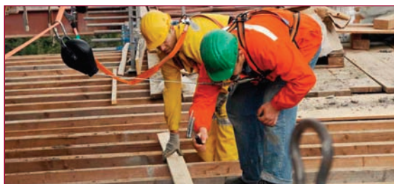
Utilización de arneses anticaídas y líneas de seguridad
