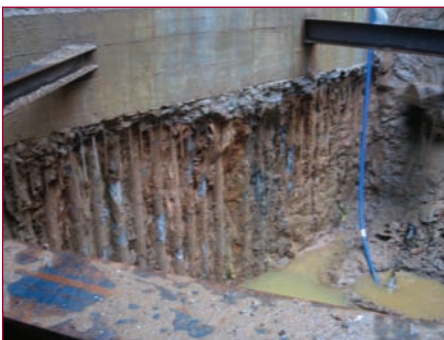
Pantalla de micropilotes tangenciales
