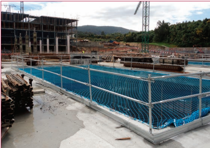
Barandilla perimetral complementada con red horizontal sobre hueco
