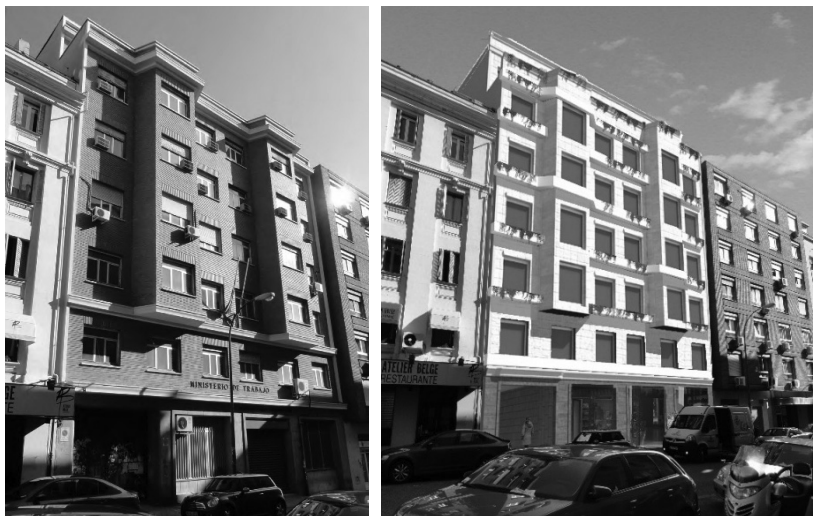
Figura 1. Estado anterior a la rehabilitación (izquierda) e imagen final del proyecto (derecha)
