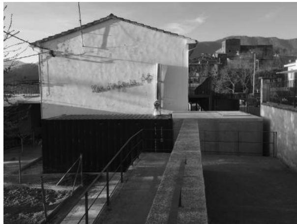
Figura 7. Contenedor metálico Biobox para caldera con silo de obra
