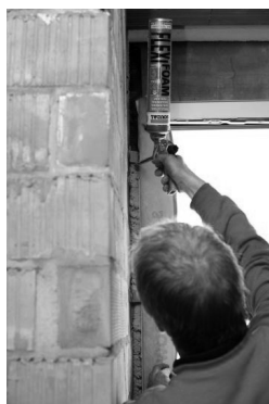
Figura 6. Aplicación en obra
