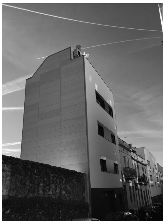
Figura 2. Edificio terminado EECN House Habitat
