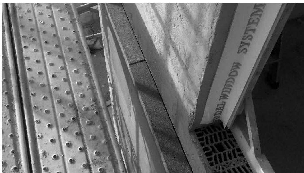
Figura 5. Bandas de estanqueidad en premarcos de ventanas
