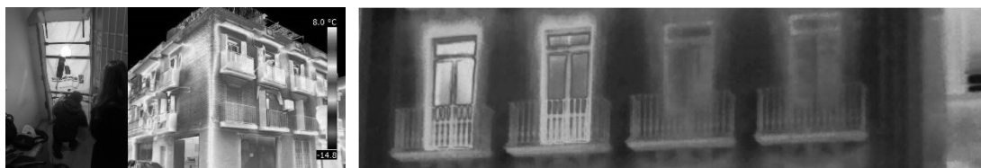
Figura 2. Imágenes termográficas y Ejecución del Test Blowerdoor
