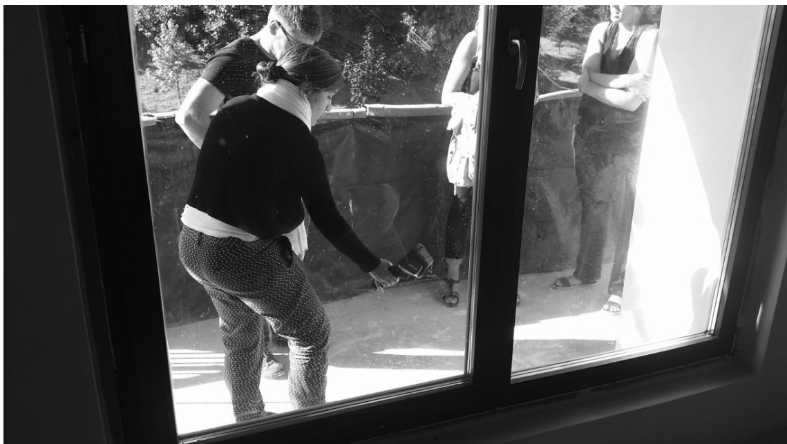
Figura 3. Inspección termográfica de los marcos de ventana
