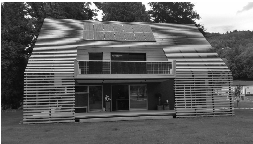
Figura 3. Vista de la casa con instalación de paneles solares
