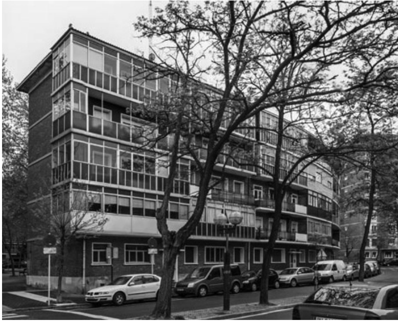
Figura 1. Estado edificio anterior a la rehabilitación
