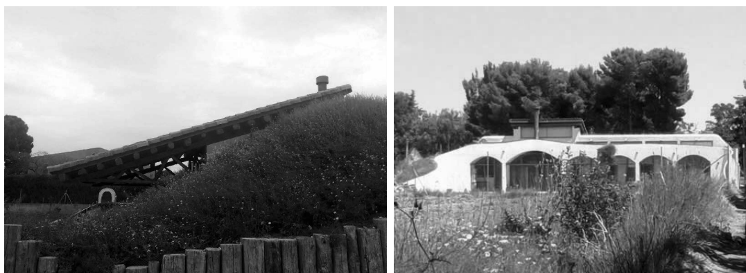
Figura 1. Fachada oeste y sur con atrios abovedados captando sol en invierno y sombreando en verano
