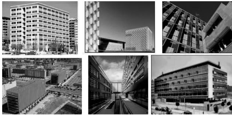
Figura 1. Edificios seleccionados y monitorizados: Metrovacesa, Telefónica, Trasluz, Grupo Ortiz, Tripark, Idom.
