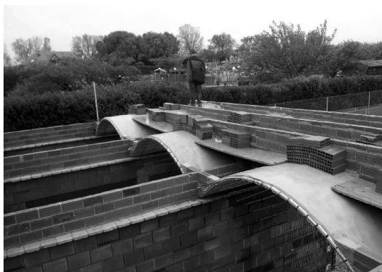
Figura 6. Bóvedas sur y bóveda norte en construcción
