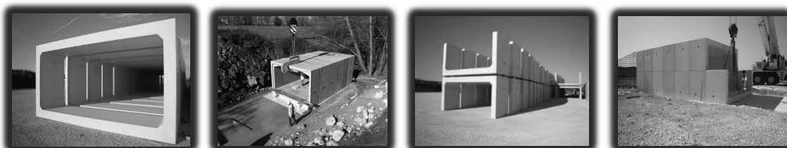
Figura 1. Marcos prefabricados cerrados y colocación; marcos prefabricados articulados y colocación
