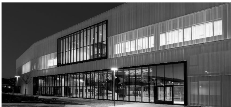
Figura 3. Vista de la fachada del edificio Fundazioia
