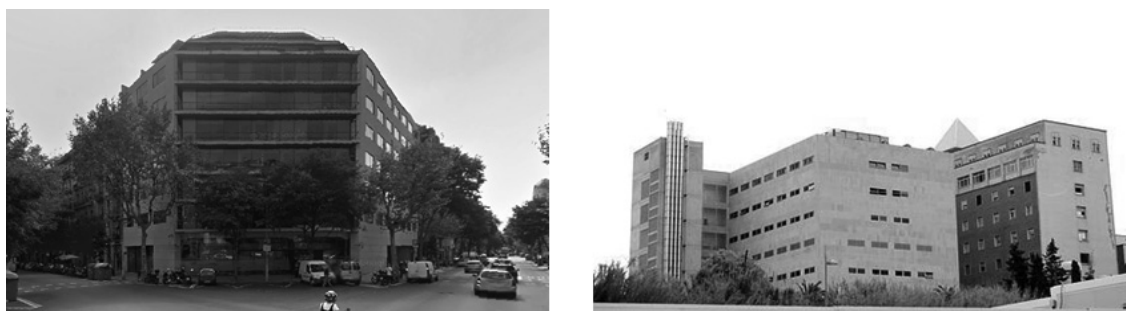
Figura 1. Edificios de referencia: Oficinas Calle Sepúlveda, Barcelona (Izquierda); Hospital Joan XXIII, Tarragona (Derecha)
