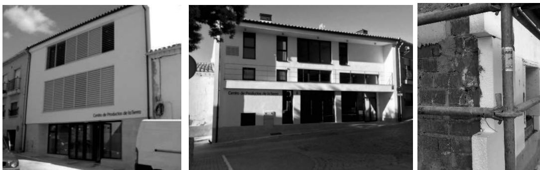
Figura 3. Fachada suroeste, fachada noreste y SATE como aislamiento de fachadas
