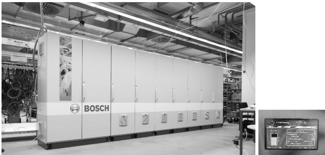
Figura 1. (izq.) Sistema de almacenamiento de una capacidad de 135 kWh fabricado desarrollado en nuestra delegación de Stuttgart. (dcha.) Display informativo del estado de la batería
