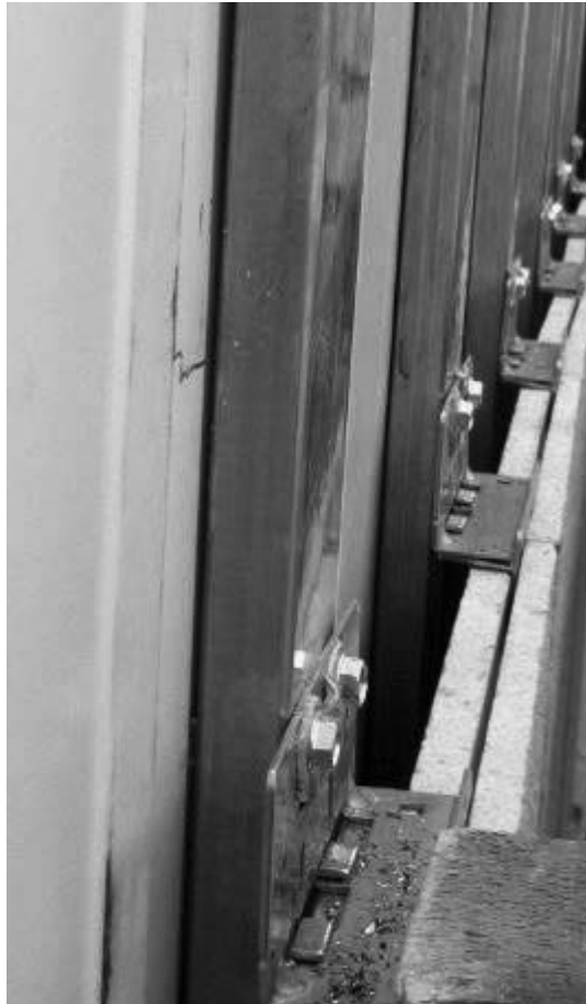
Figura 7. Puesta en obra de grapas
