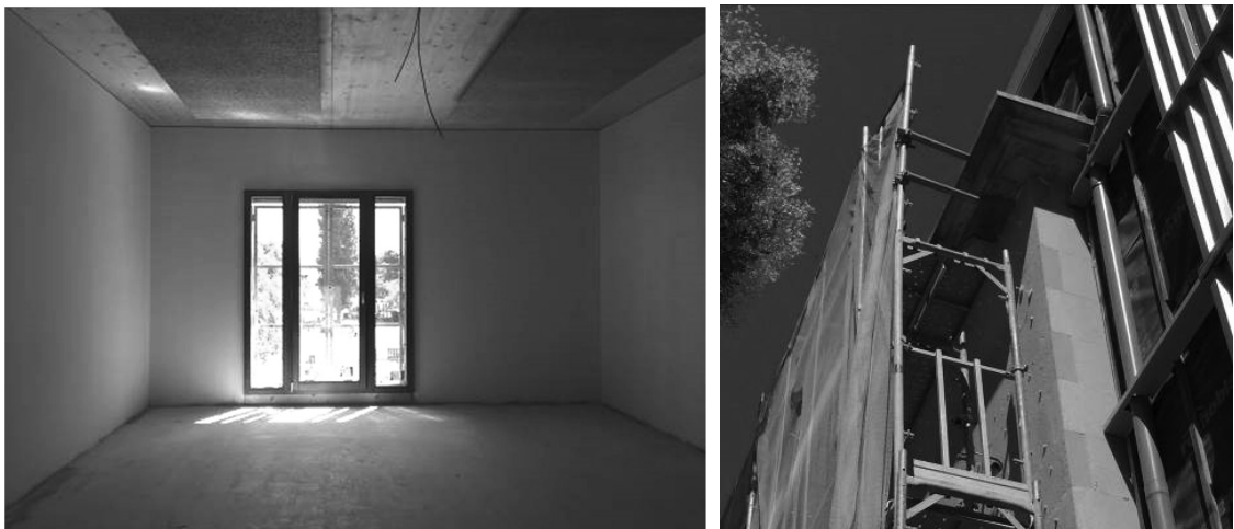
Figura 5. Interior de una de las salas de planta primera e imagen de los 12 cm de fibra de madera como aislante perimetral exterior de la fachada existente
