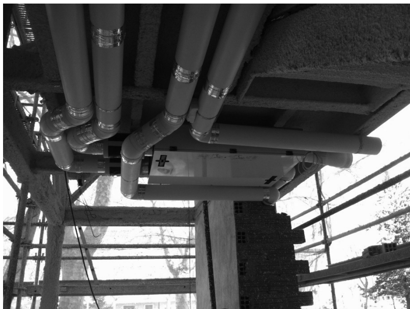
Figura 5. Imagen durante la instalación del Sistema Ventilación
