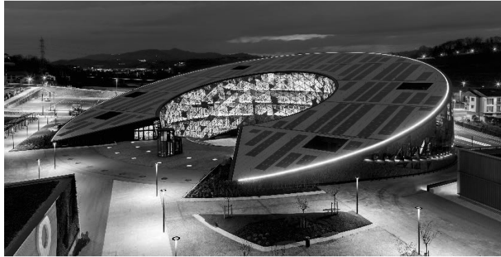
Figura 1. Vista de la fachada Sur de Zero
