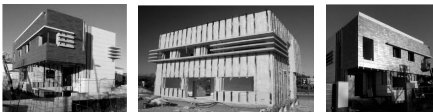
Figura 8. Estado actual de las obras
