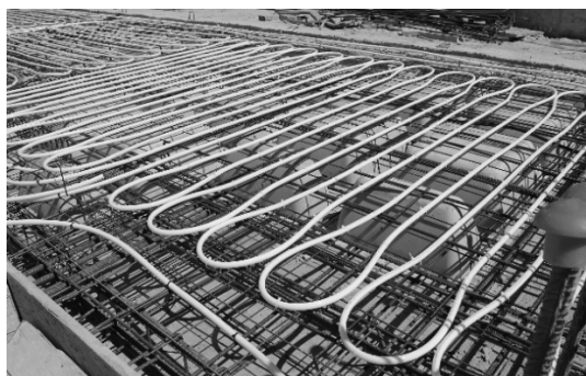
Figura 9. Instalación sistema Termoactivación
