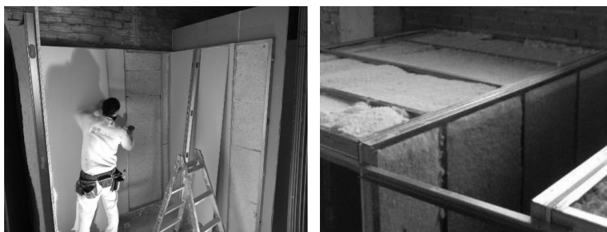
Figuras 6 y 7. Instalación del material en obra
