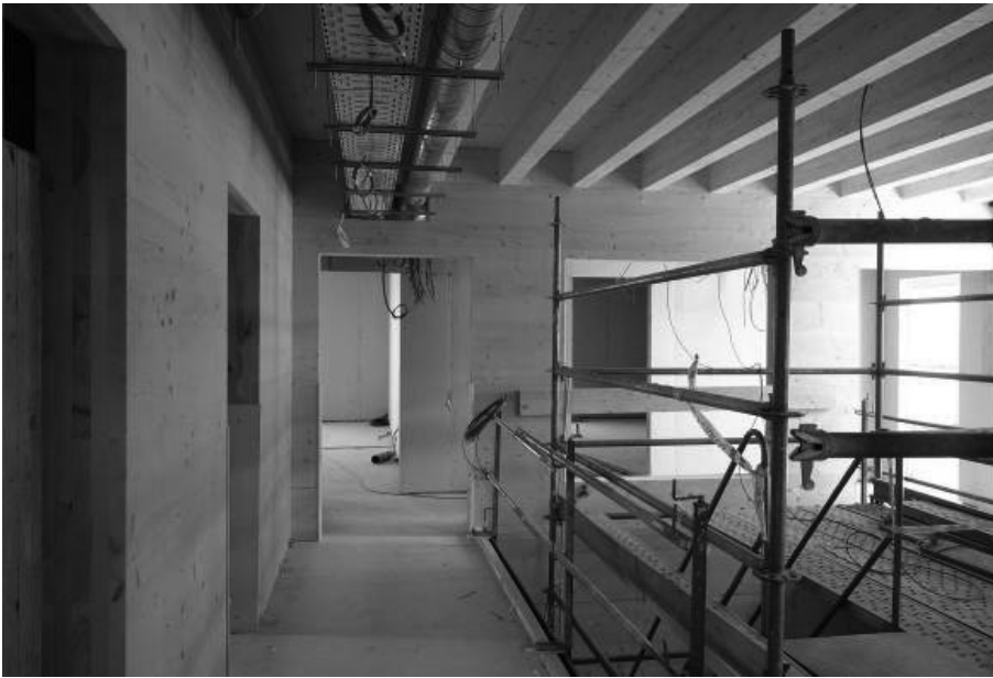
Figura 4. Espacio central de circulaciones con el atrio y lucernario con anillo de instalaciones vistas con paneles de absorción acústica
