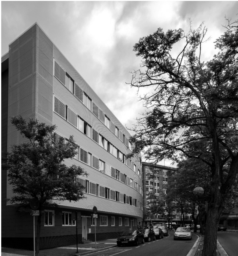
Figura 2. Estado edificio rehabilitado
