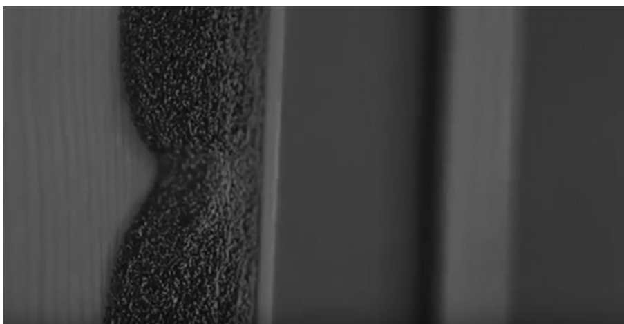
Imagen 2. Detalle de aplicación de la espuma impregnada (illmod Trio TP650)
