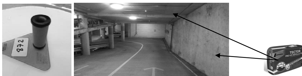
Figura 6. Sensores captadores de la concentración de NO 2 . Prueba de campo realizada el aparcamiento público Escuelas San Antón. Señalización de las zonas de aplicación
