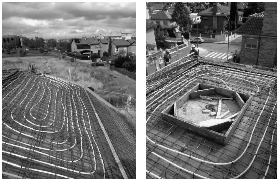
Figura 2. Activación de losa de hormigón
