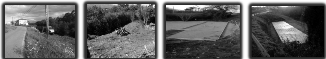
Figura 2. Desbrozado, acondicionamiento agregando una solera de limpieza en el lugar de ubicación
