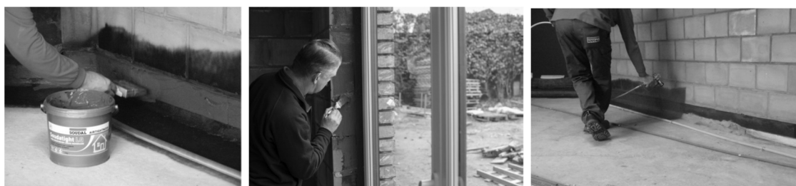
Figura 12, 13 y 14. Puesta en obra de membrana líquida
