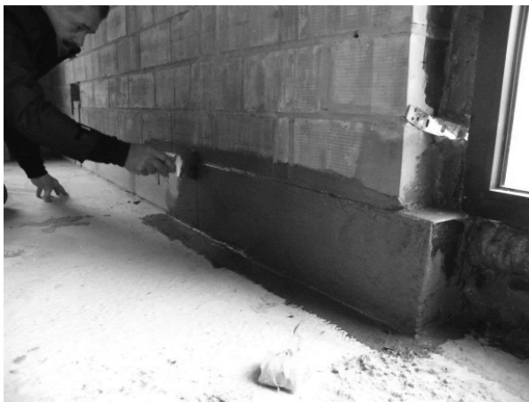
Figura 13 y 14. Puesta en obra de membrana líquida y Máquina airless para obra mayor.
