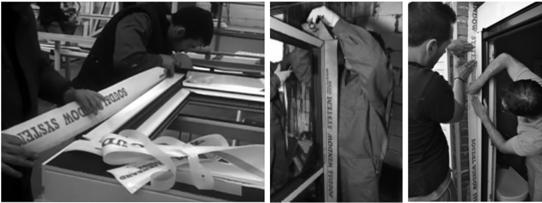
Figura 10, 11 y 12. Puesta en obra de barreras de vapor
