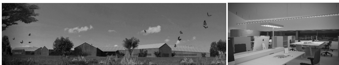
Figura 3. Vistas de la fachada exterior y del interior de uno de los módulos del edificio
