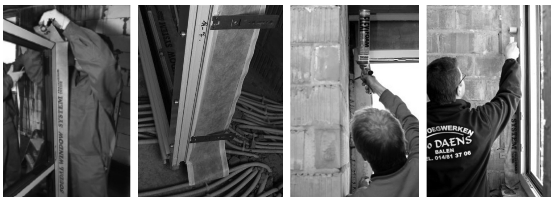
Figuras 8, 9, 10 y 11. Puesta en obra de barrera de vapor interior
