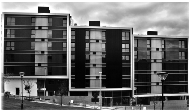
Figura 2. Conjunto de 32 Viviendas Sociales EECN en Portugalete (Bizkaia) y los tres sistemas de fachada sur: Panel sándwich aislante (izq), fachada SolarWall (centro) y fachada con Muro Trombe (dcha.)
