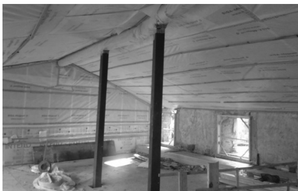
Figura 2. Láminas interiores insufladas
