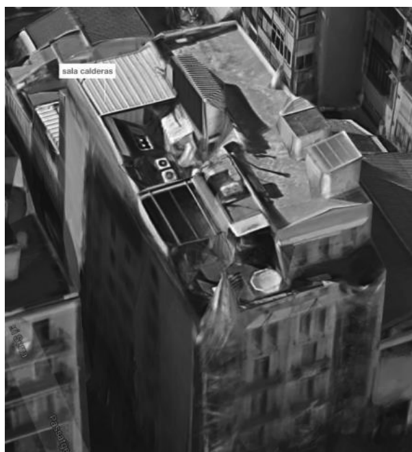
Figura 5. Contenedor metálico Biobox en azotea
