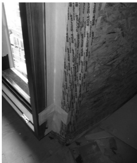
Figura 3. Encuentro de carpintería con tablero OSB
