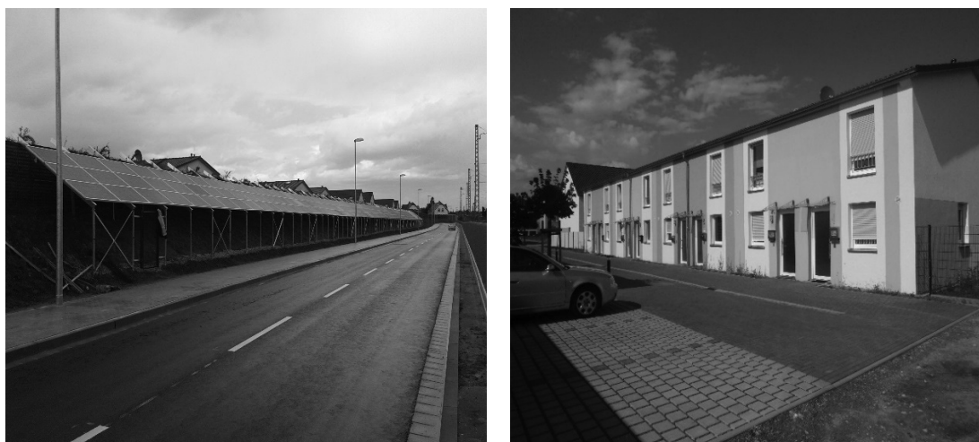
Figura 3. (izq.) Foto de la instalación solar fotovoltaica (dcha.) Foto del complejo residencial
