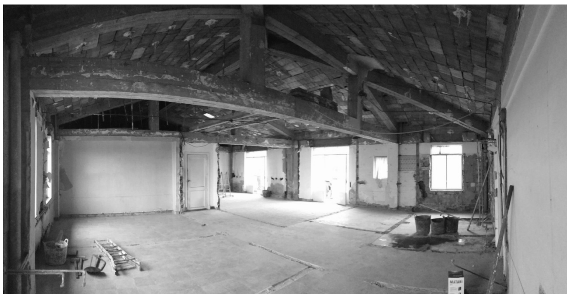
Figura 1. Espacio diáfano tras la retirada de la compartimentación y el falso techo existente
