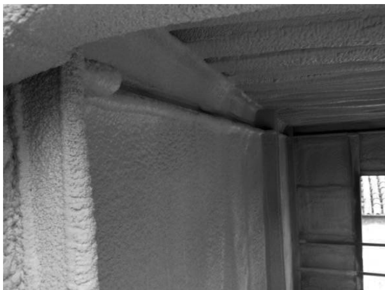
Figura 4. Proyectoado interior de elementos verticales y horizontales
