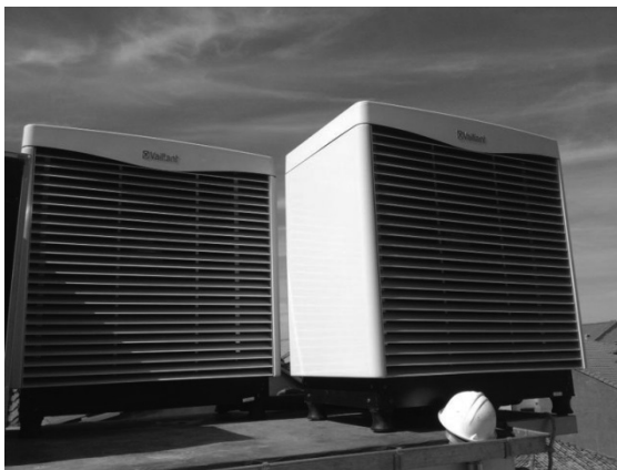
Figura 2. Instalación Unidades Exteriores Bomba de Calor
