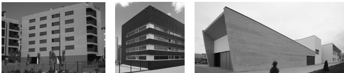
Figura 2. Ejemplos de obras realizadas con STRUCTURA
