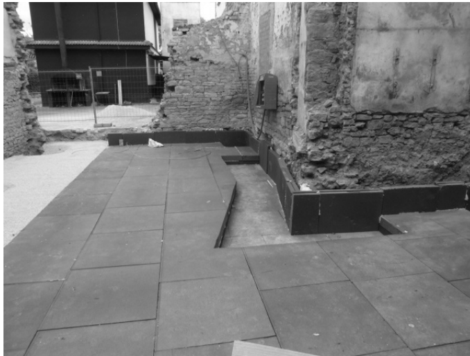
Figura 4. Placas EPS bajo losa de cimentación
