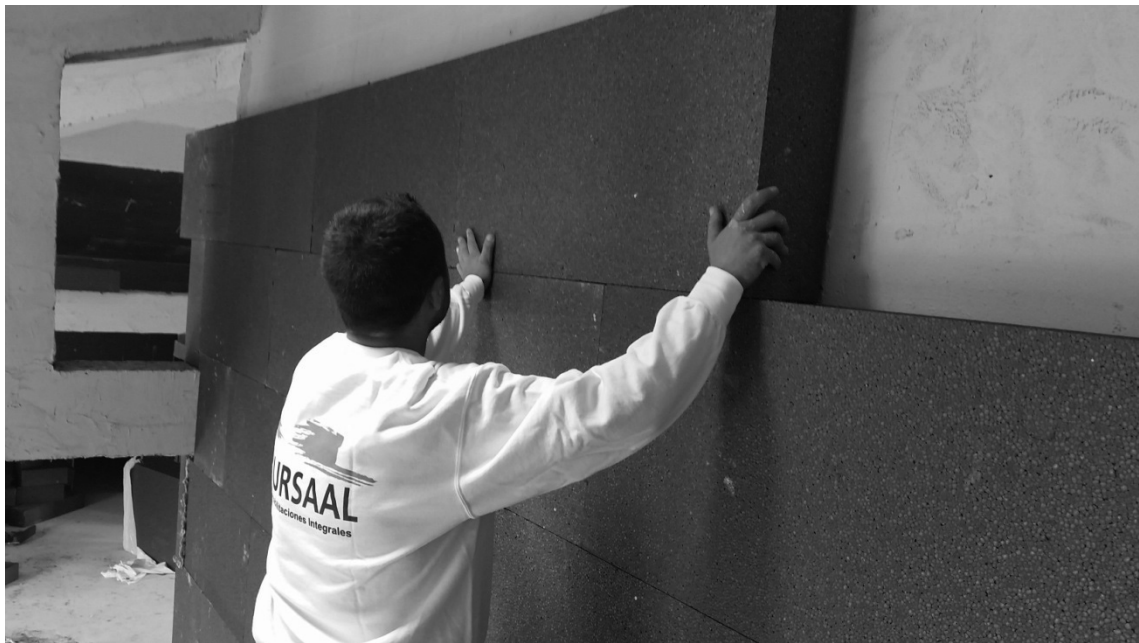
Figura 2. Colocación de aislamiento de poliestireno expandido aditivado con grafito por el interior
