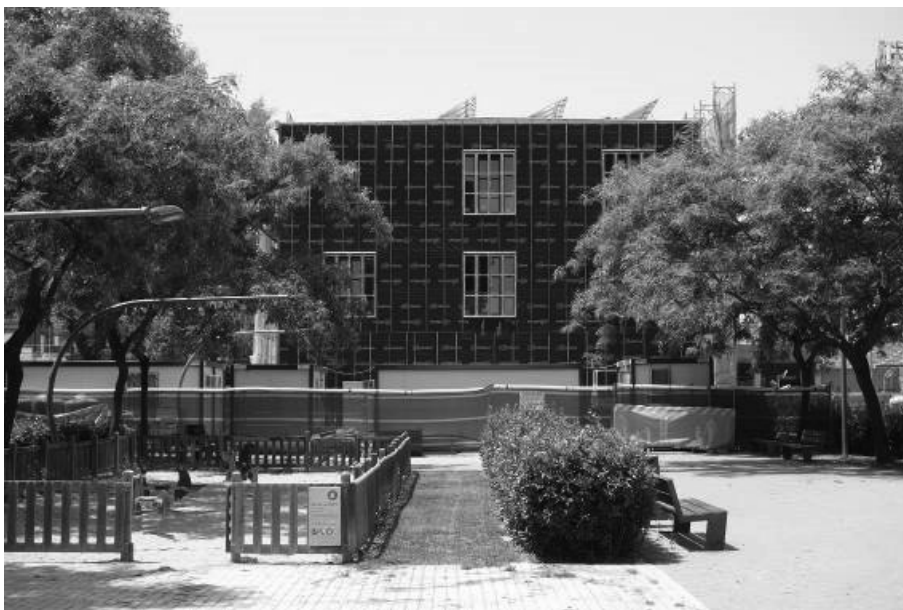
Figura 7. Vista de la fachada este con unos paneles fotovoltaicos en la coronación del edificio
