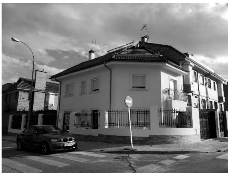
Figura 1. Vivienda unifamiliar en barrio de Barajas, Madrid
