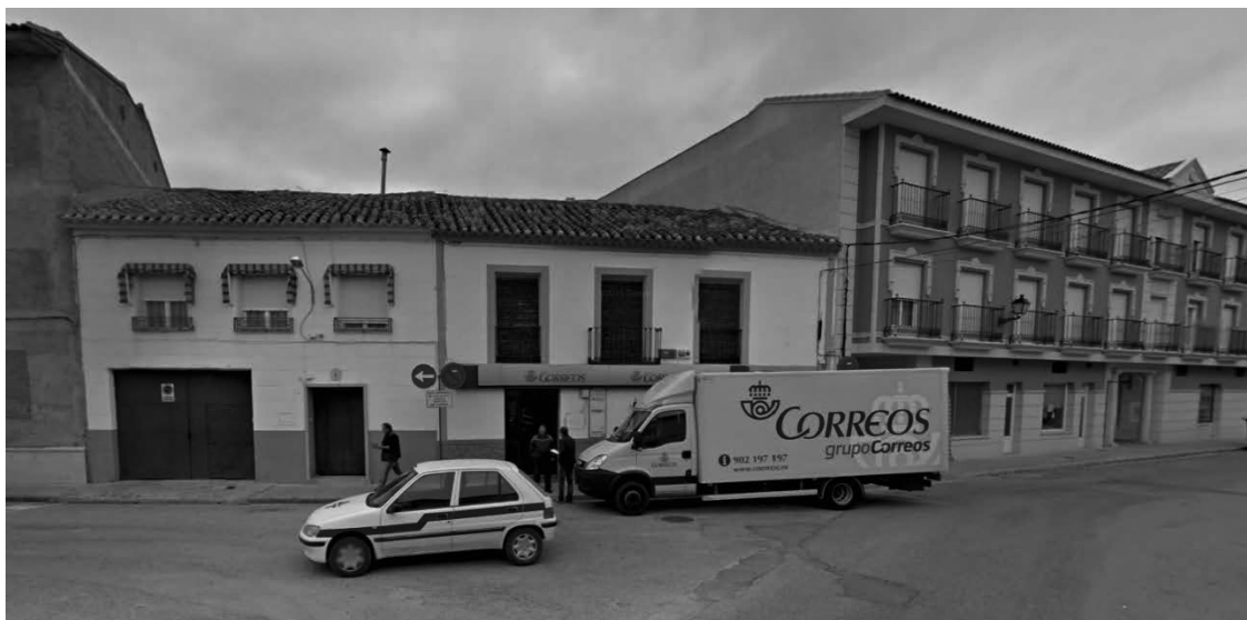
Figura 1. Foto del actual edificio situado en la c/Paz 4, Argamasilla de Alba (Ciudad Real)
