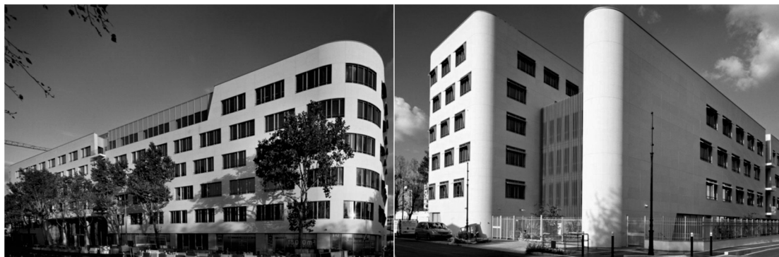
Figura 3. Edificio de Oficinas “NEWSIDE” - Francia
