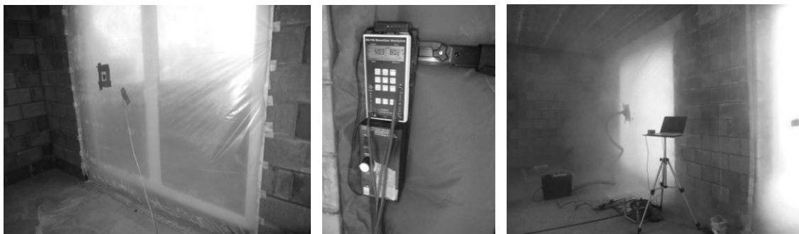
Figura 18, 19 y 20. Blower Door y Prueba de humo
