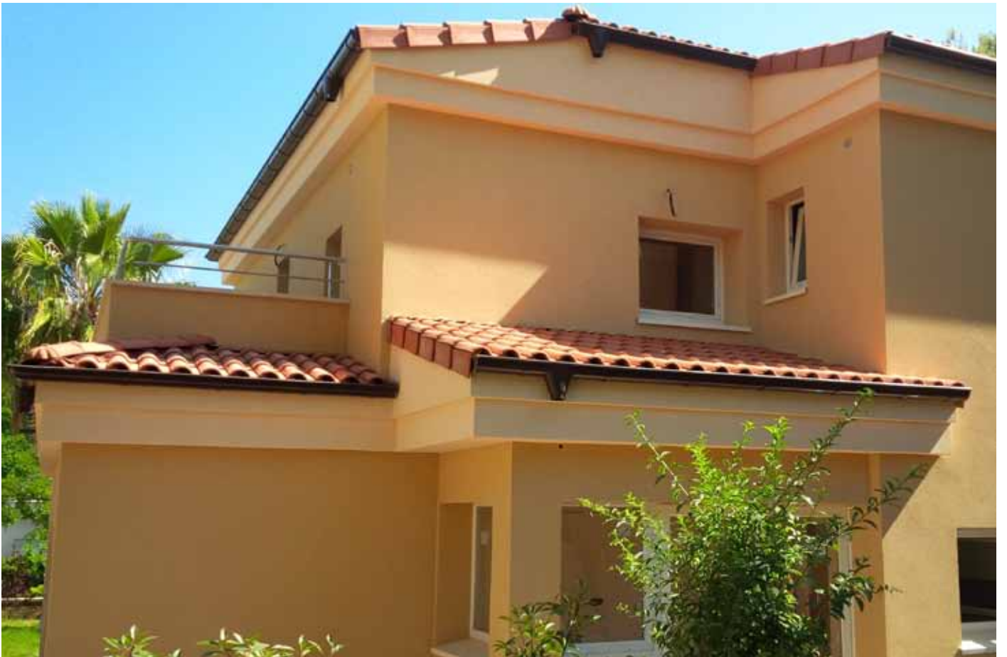
Obra finalizada, vivienda rehabilitada
