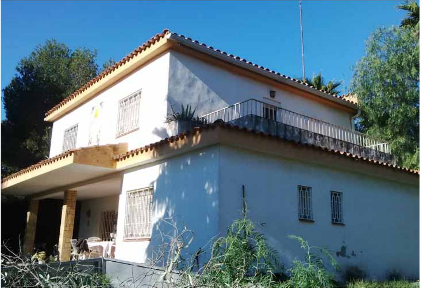
Estado inicial, antes de la rehabilitación
