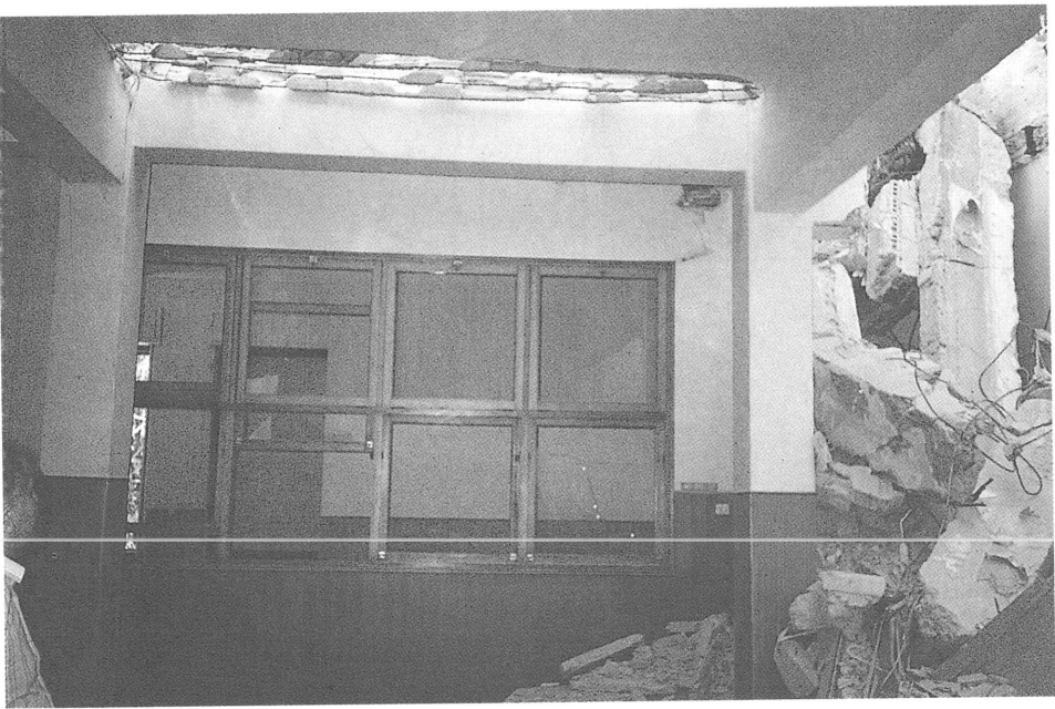
Foto 45. Proceso de derribo de un pórtico de hormigón armado.
