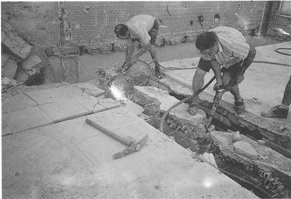
Foto 50. Proceso de derribo de un pórtico de hormigón armado.
