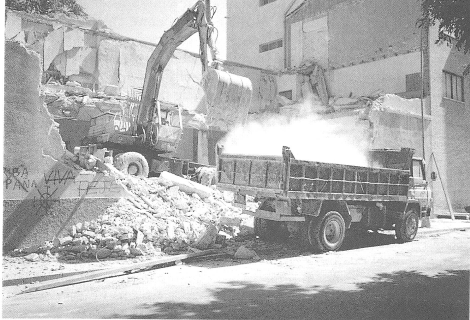
Foto 79. Descontrol máximo en la carga y retirada de escombros.
