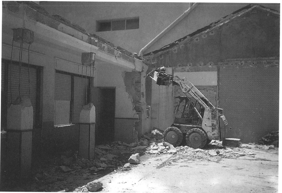
Foto 27. La maquinaria ligera permite, incluso, su uso en las distintas plantas del edificio.
