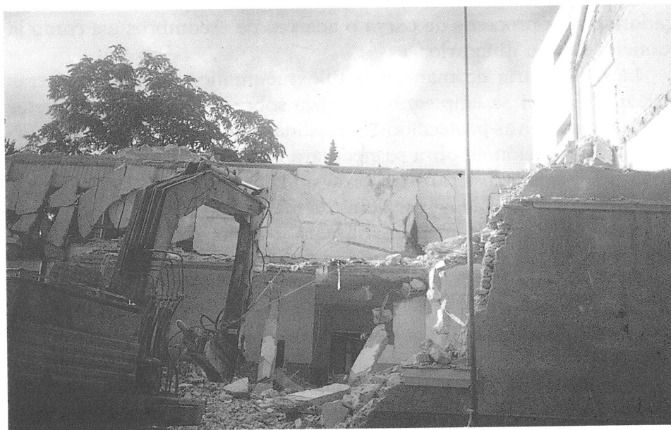
Foto 75. Derribo por tracción con cable trenzado de acero.
