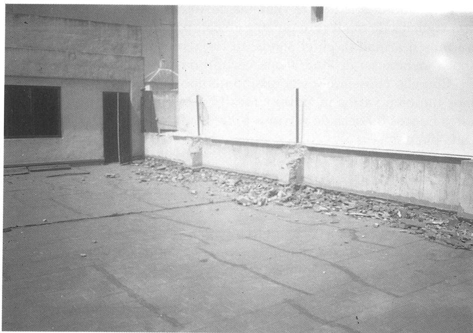
Foto 33. Antes de la apertura de los huecos hay que derribar los elementos necesarios para ello.
