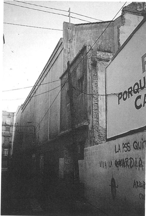
Foto 16. Los tendidos que discurrir por las fachadas, se retirarán antes de iniciar la Demolición.
