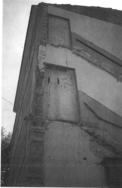
Foto 2. Ejemplo de apuntalamiento y tabicado de hueco en medianera.
