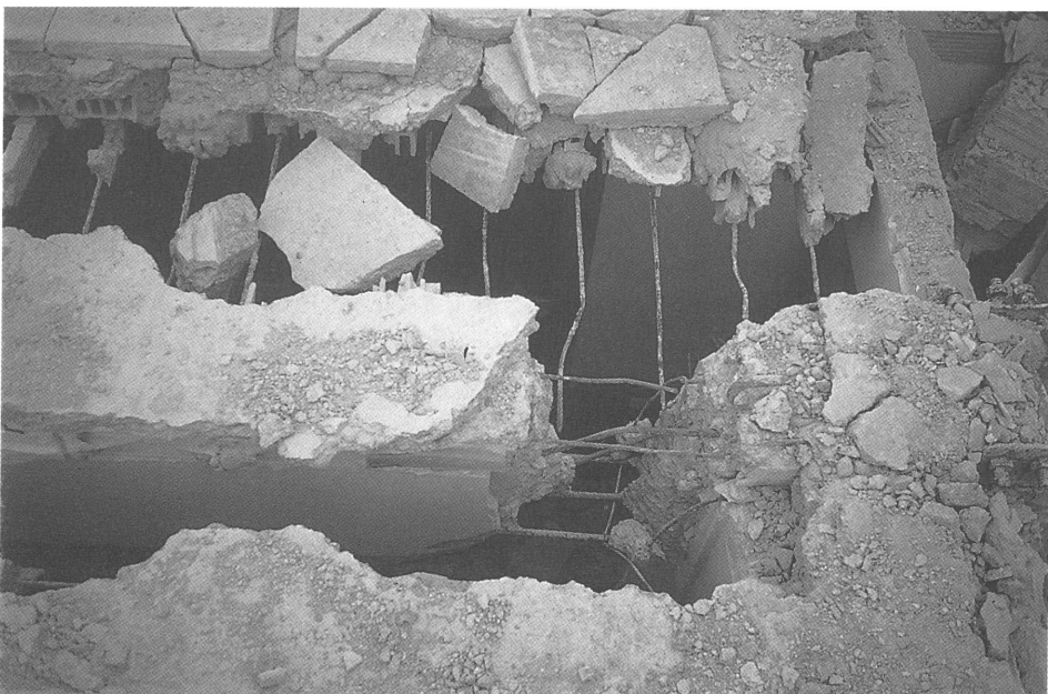
Foto 48. Proceso de derribo de un pórtico de hormigón armado.
