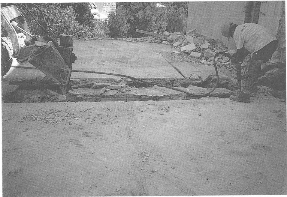
Foto 46. Proceso de derribo de un pórtico de hormigón armado.
