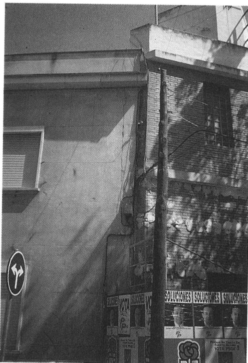
Foto 67. Se debe estudiar el edificio detenidamente antes de comenzar la demolición.
