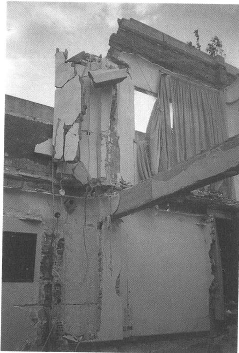
Foto 35. Esta situación no debe producirse en el proceso de demolición.
