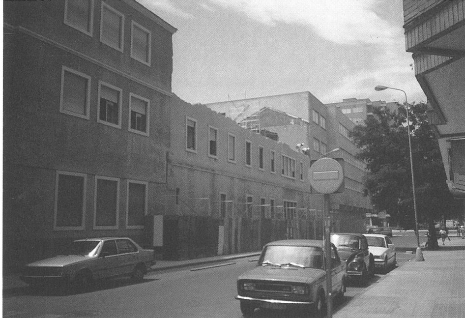
Foto 29. En este caso los andamios de fachada no se deberían haber retirado todavía.
