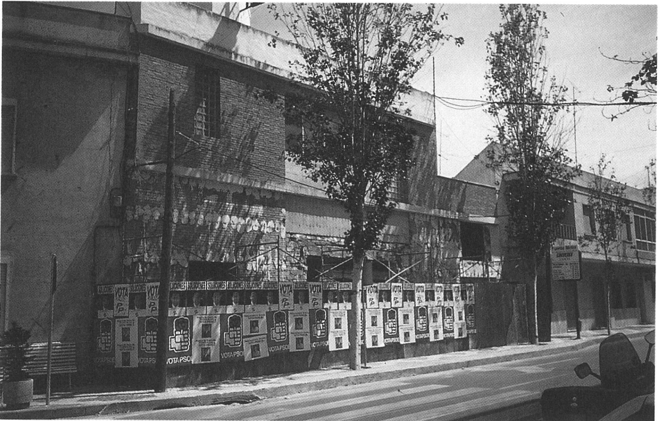
Foto 11. Protección y ampliación de acera peatonal.
