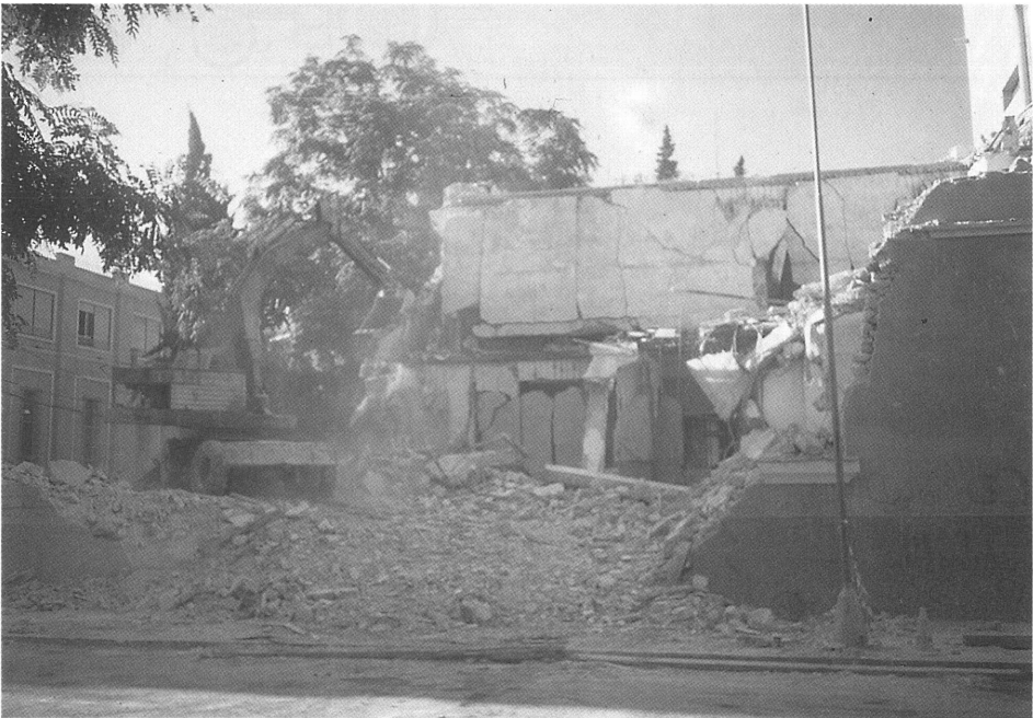
Foto 72. Ataque máximo de pala retroexcavadora.
