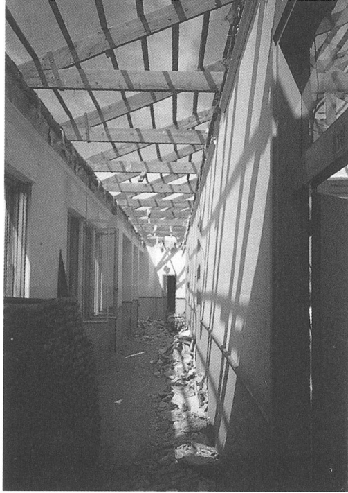
Foto 37. Siempre el primer elemento a derribar ha de ser la cubierta del edificio.
