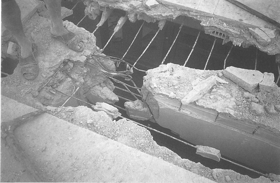
Foto 47. Proceso de derribo de un pórtico de hormigón armado.
