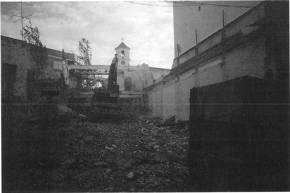
Foto 3. Adecuación de la maquinaria al espacio disponible.
