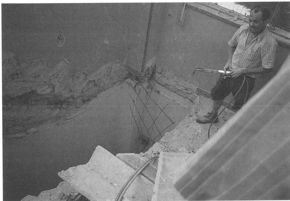
Foto 42. La escalera siempre será lo último a derribar en cada planta del edificio.
