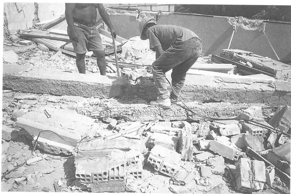
Foto 44. Las armaduras en el hormigón armado se desconocen.
