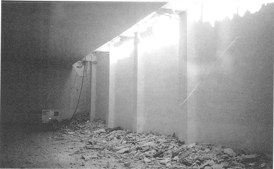
Foto 23. Ejemplo de hueco para el vertido de escombros junto a la medianera.
