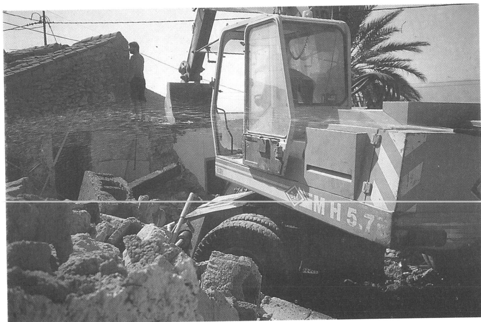
Foto 78. Operación de regado de escombros de fácil ejecución.
