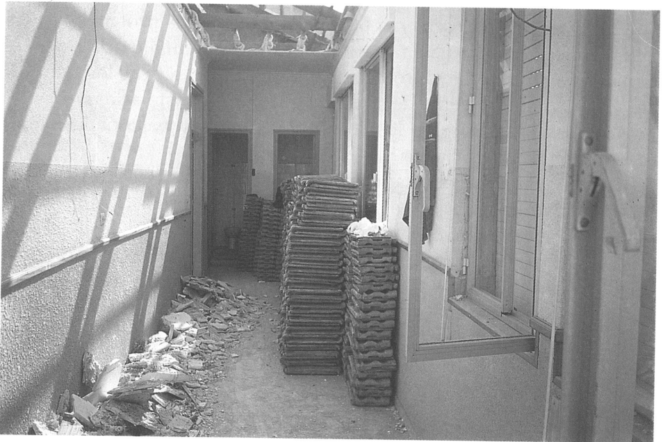
Foto 17. El material de cubiertas (tejas) se suele retirar siempre para una posterior reutilización.
