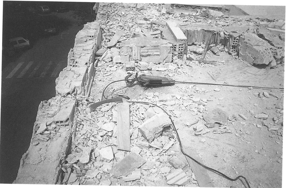
Foto 68. Tractel utilizado en los derribos por tracción.
