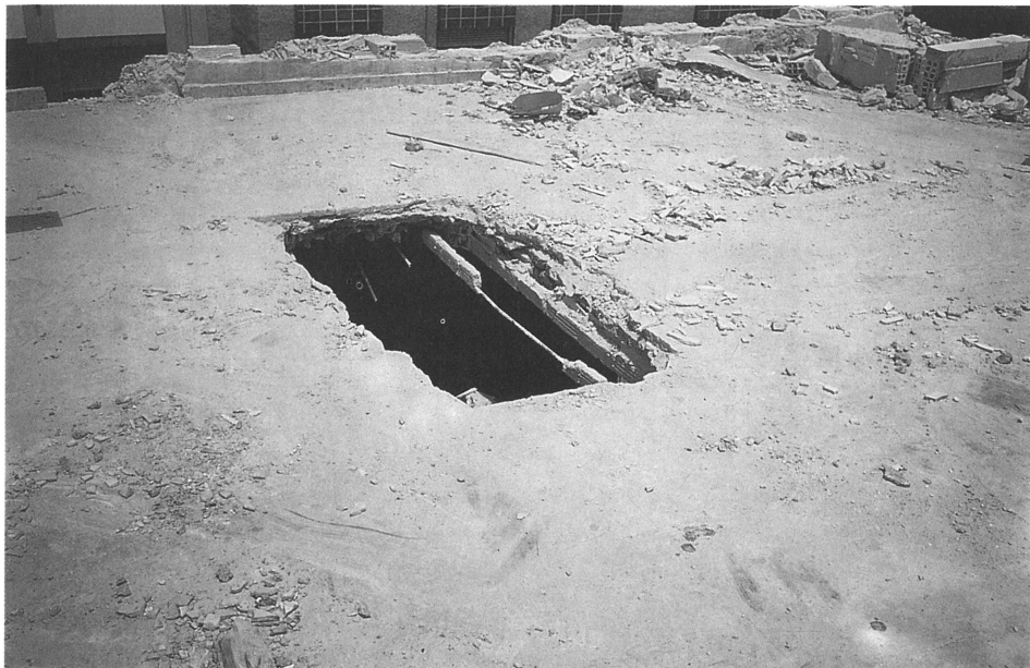
Foto 24. El hueco para el vertido de escombros tendrá el mismo ancho que la distancia entre ejes de viguetas.
