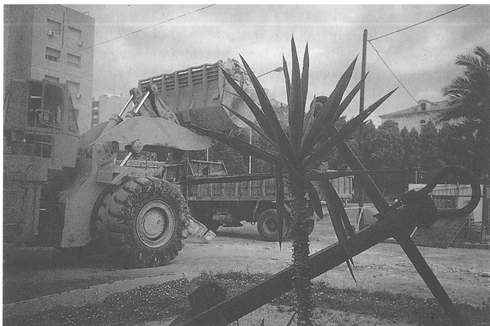
Foto 80. El movimiento de maquinaria exige el corte del tráfico rodado y vallado de la zona de peligro.
