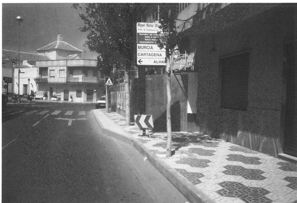
Foto 5. Ampliación de aceras y señalizaciones necesarias.
