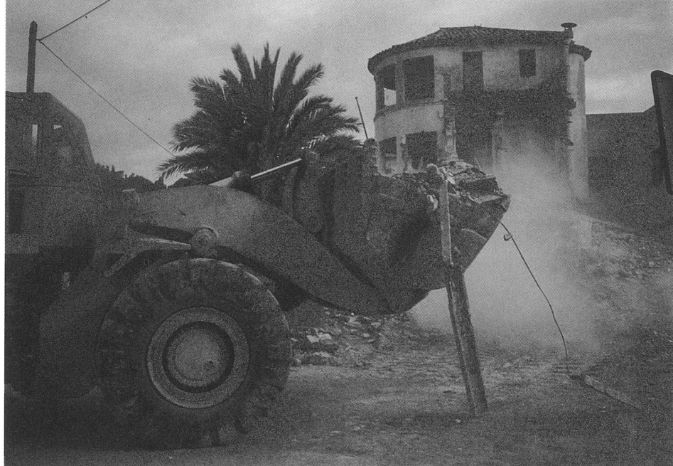
Foto 4. Dificultades en la retirada de escombros.
