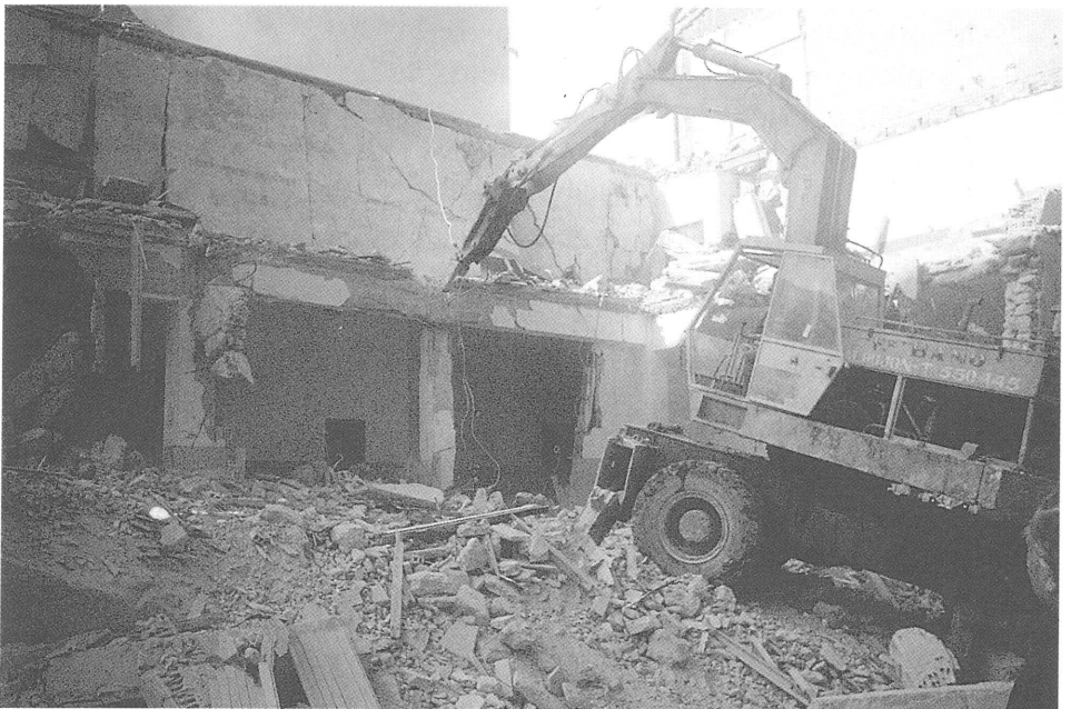
Foto 70. Detalle de martillo rompedor en máquina retroexcavadora. Muy efectivo.
