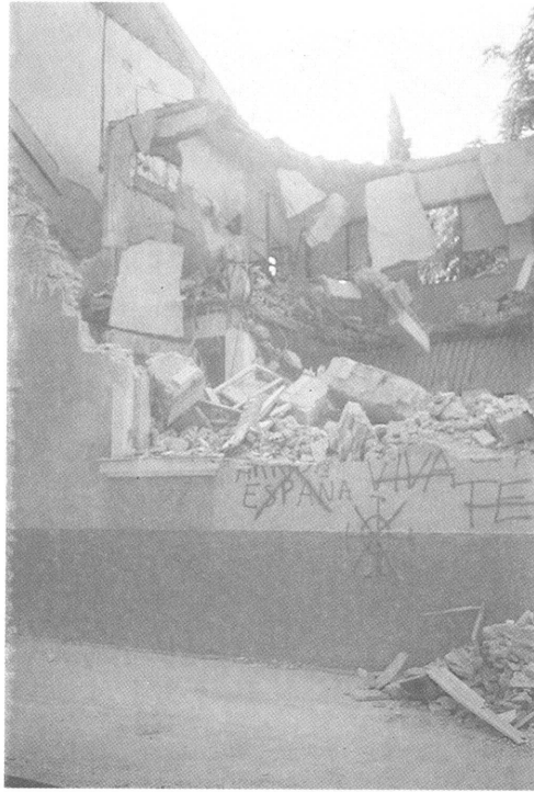
Foto 7. El escombro deberá reducirse antes de su carga en el camión.
