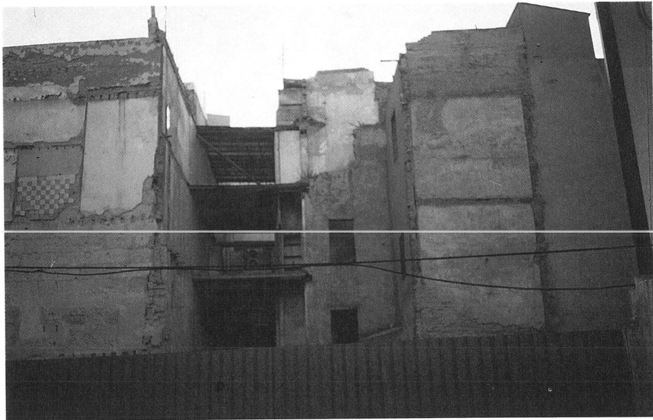
Foto 62. Ejemplo de acodamiento de medianeras aprovechando el entrecigado.
