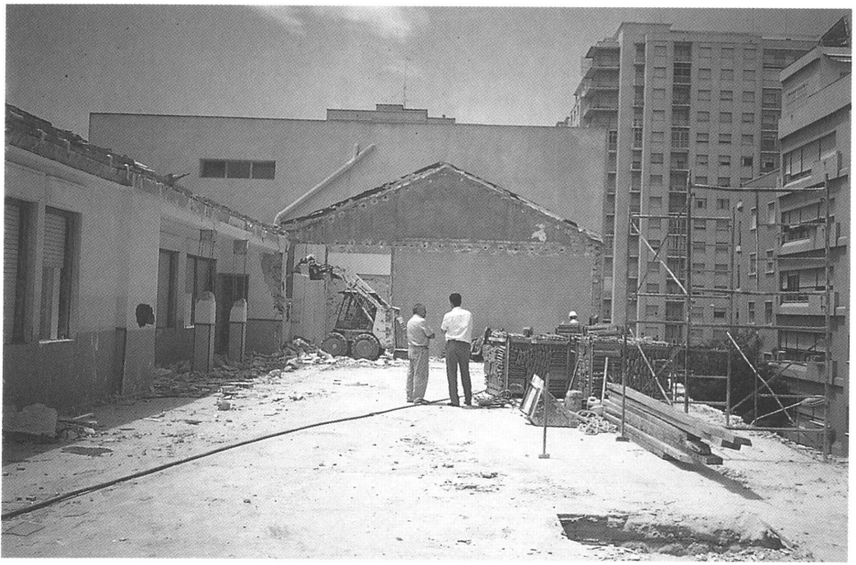
Foto 34. Los trabajos de demolición siempre seguirán el sentido descendente.
