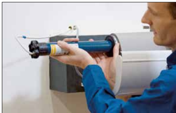
Figura 126. Motor tubular
