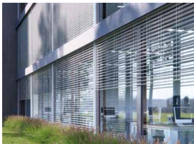
Figura 88. Persiana graduable de lama de cantos rebordeados
