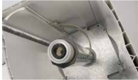
Figura 79. Detalle interior cajón de persiana
