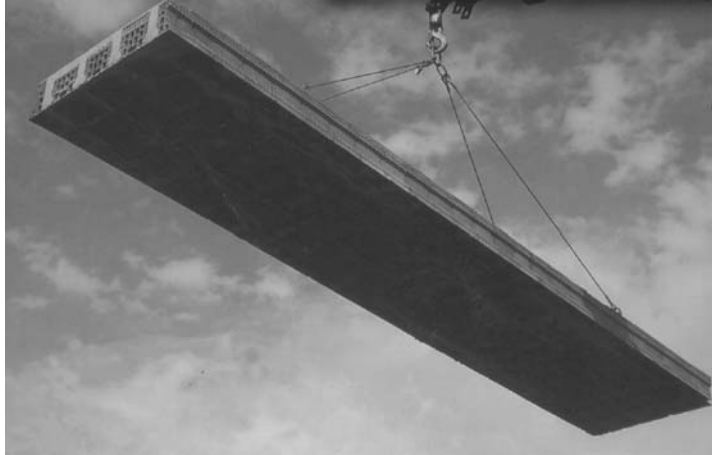
Placa cerámica pretensada elevada mediante grúa
