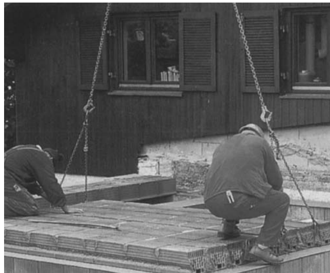
Forjado con placa cerámica pretensada
