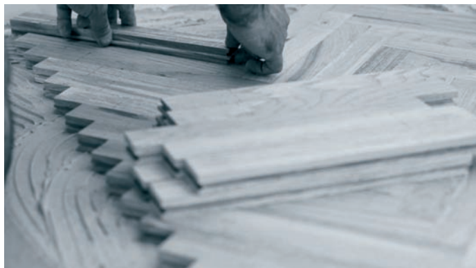
Figura 50 Colocación de parquet pegado. Fuente: AIDIMA (2010).
