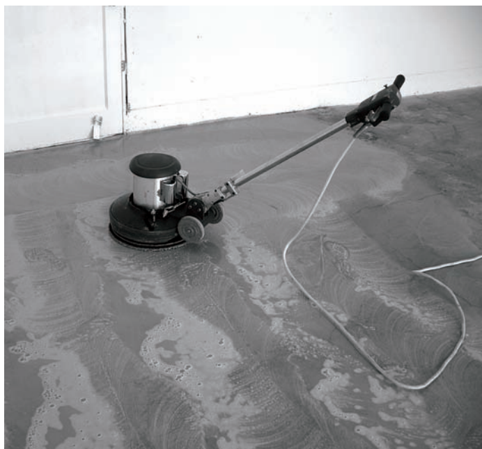
Figura 40 Reparación de grietas en solera. Fuente: www.cleanerbyfarr.com
