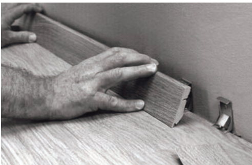
Figura 74 Zócalo de madera con canales para el transporte de cables. Fuente: www.foakat.es
