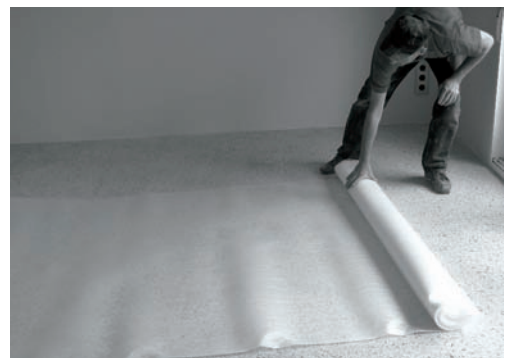
Figura 58 Colocación del aislante. Fuente: AIDIMA (2010).
