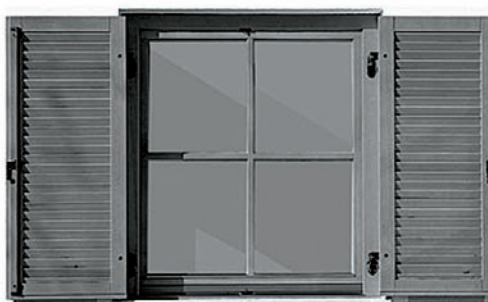
Figura 30 Ejemplo de contraventana mallorquina. Fuente: ASEMAAD.
