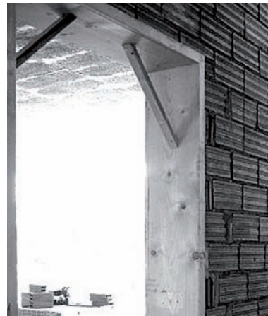
Figura 35 Replanteo de hueco de ventana con precerco. Fuente: AIDIMA (2010).
