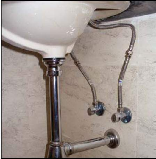
Fig 3. Conectores flexibles
