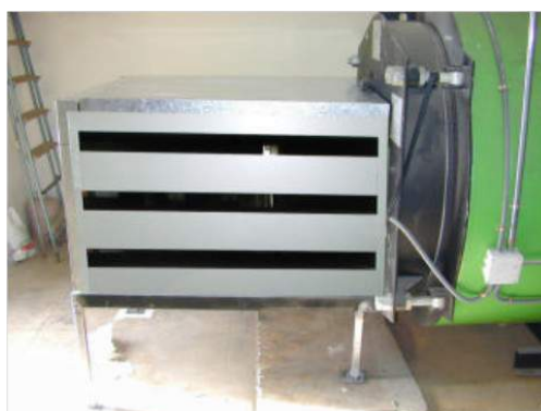
Fig 3. Quemador con encapsulado
