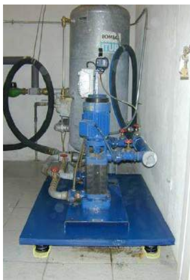
Fig 3. Ejemplo bancada inercia
