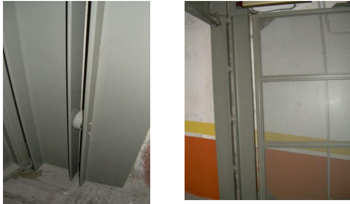
Fig 2. Ejemplo de colocación de amortiguadores sobre estructura de la puerta
