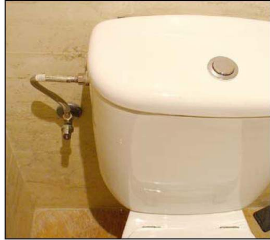
Fig 4. Conectores flexibles
