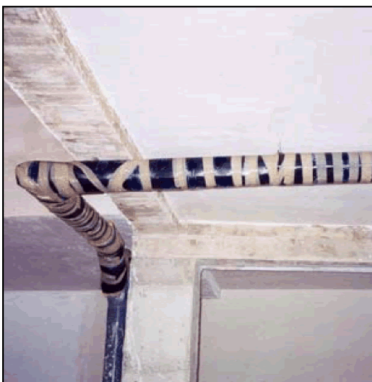
Fig 1. Aislamiento de colector de ubicación
