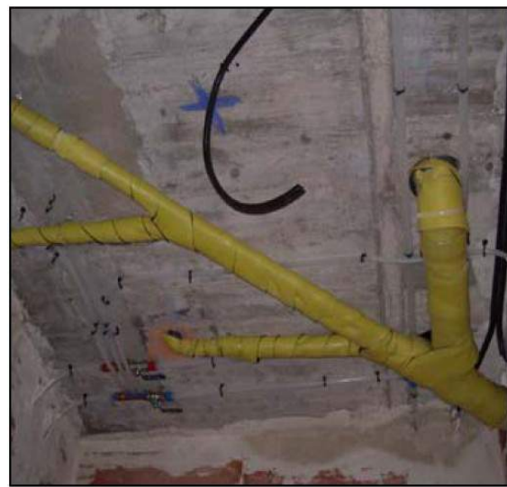
Fig 2. Aislamiento de pulpo de desagüe
