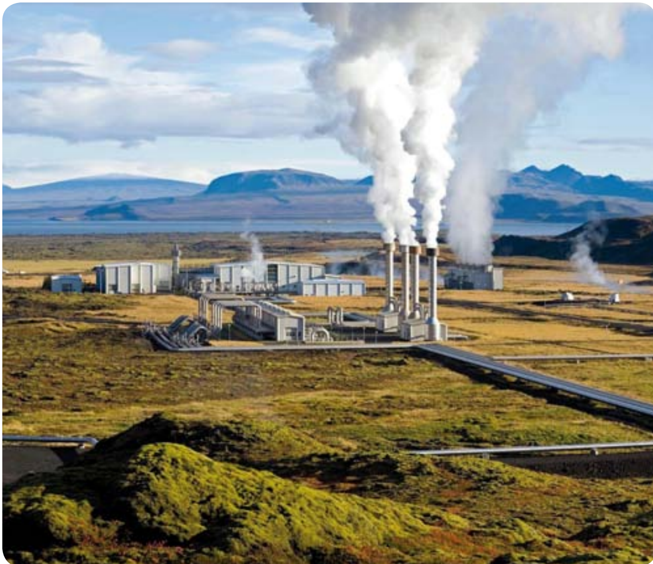
Planta Geotérmica de Nesjavellir en Islandia.
