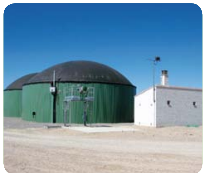
Planta de digestión anaerobia de purines de cerdo con mezcla de otros residuos orgánicos.
