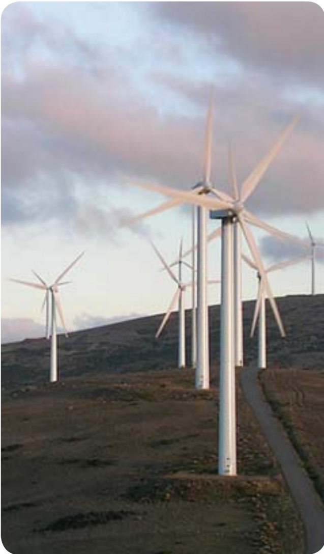
Parque Eólico de Aldeavieja (Ávila).
