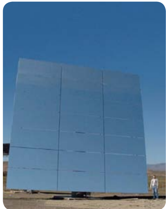
Helióstato de vidrio-metal de 90 m 2 de superficie reflexiva.
