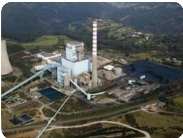
Central Térmica de Meirama (La Coruña).
