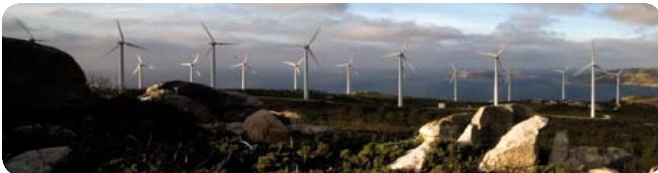
Parque Eólico de Malpica de Bergantiños (La Coruña).
