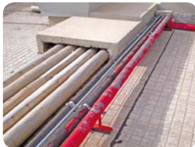
Aislamiento deteriorado.
