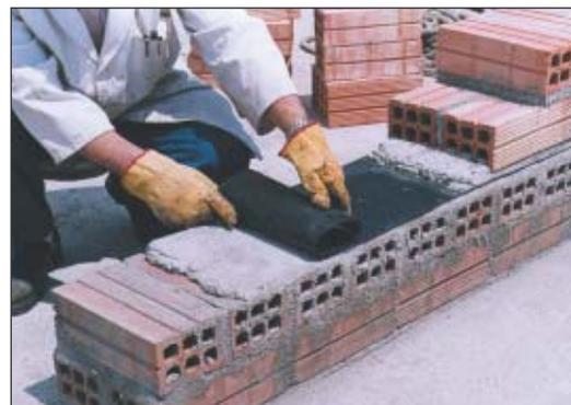
Colocación de barrera anticapilaridad con lámina autoadhesiva
