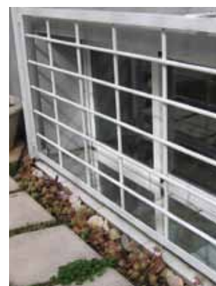
Espejos en la parte baja de la emboadura de la ventana. Conjunto de 26 viviendas bioclimáticas en Madrid. Arquitectos: M. de Luxán, F. de Celis, E. Echevarría, F. da Casa.
