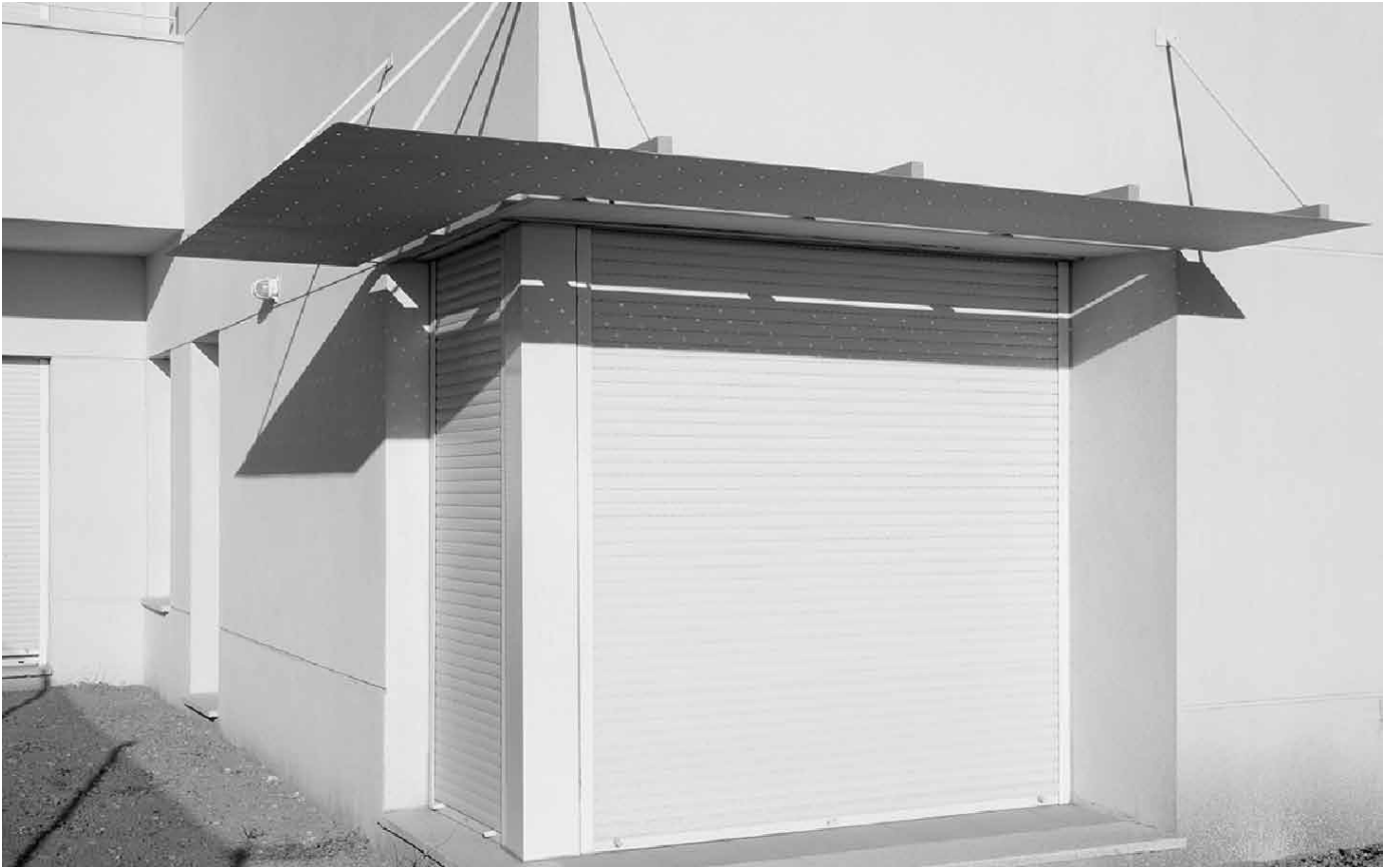
Elemento para sombra sobre ventana captora, obstrucción solar en invierno. Conjunto de 351 viviendas bioclimáticas en El Toyo, Almería. Arquitectos: M. de Luxán, R. Tendero, P. Nau.
