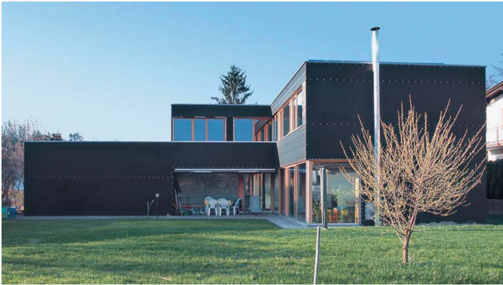
Fotografía 12. Vivienda en Vorarlberg (Austria). Fuente: iPHA.
