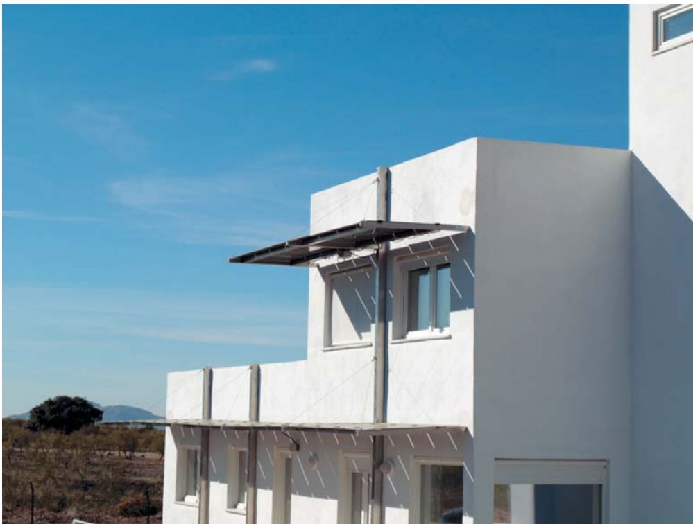
Fotografía 14. Casa unifamiliar en Moraleda de Zafayona. Fuente: Ecoholística.
