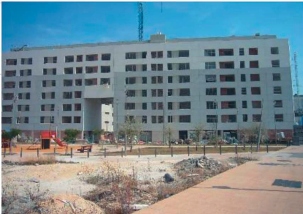
Fotografía 1. Edificio en fase de construcción.
