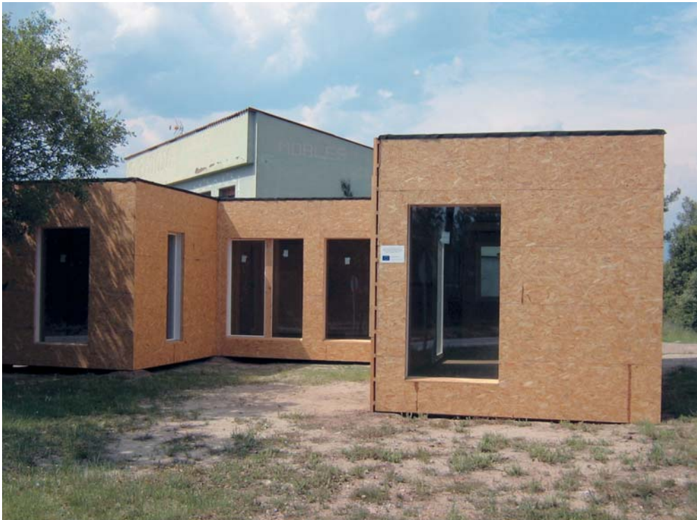
Fotografía 21. Casa EcoOci, estado actual. Fuente: EcoOci.
