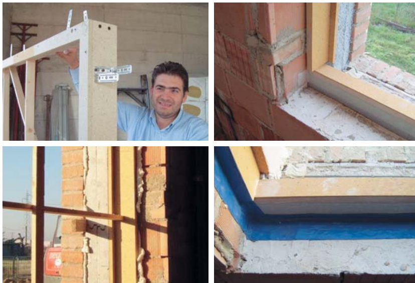
Fotografía 8. Montaje premarco de la carpintería. Fuente: TBZ.
