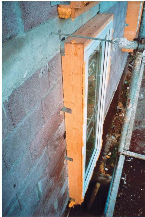
Fotografía 2. Imagen de comprobaciones en obra de la posición de la ventana en el plano del aislamiento térmico.
