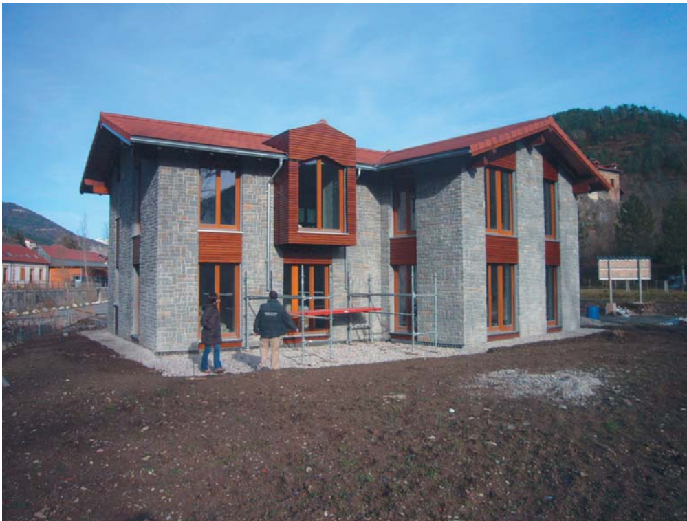
Fotografía 15. Casa Pasiva Arias en Roncal, Navarra. (2ª casa con certificado provisional en España). Fuente: Wolfgang Berger.
