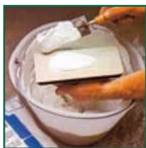
Llana de goma dura y filo vivo para el correcto embutido y rebañado del material
