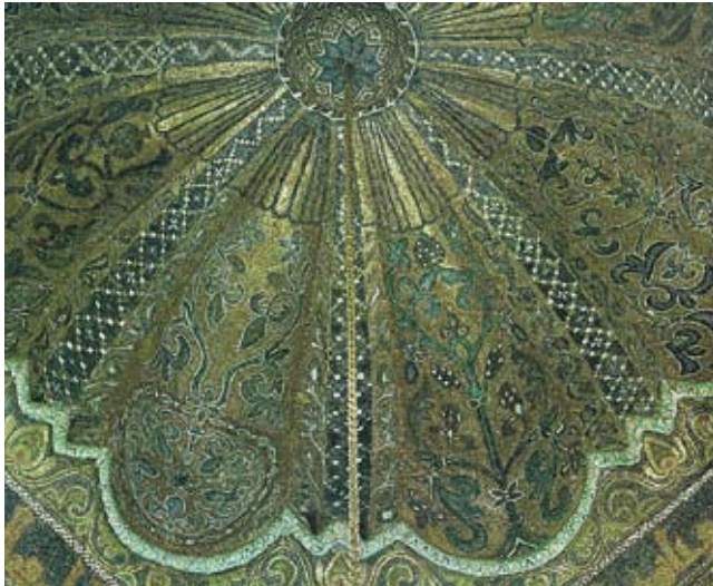
Bóveda de la maxura en la mezquita de Córdoba. Ampliación de al-Hakam II, 961-976. Decoración musivaria de teselas de vidrio dorado (técnica bizantina) e imposta mixtilínea de cerámica vidriada y decoración
