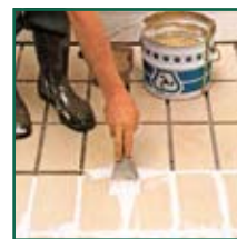
Epátula de acero inox. para el embutido de materiales RG
