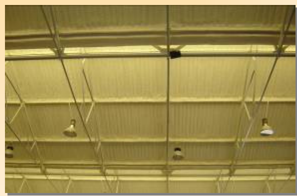
Cubierta de chapa aislada con poliuretano
