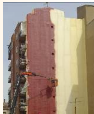
Proyección en medianera con protección
