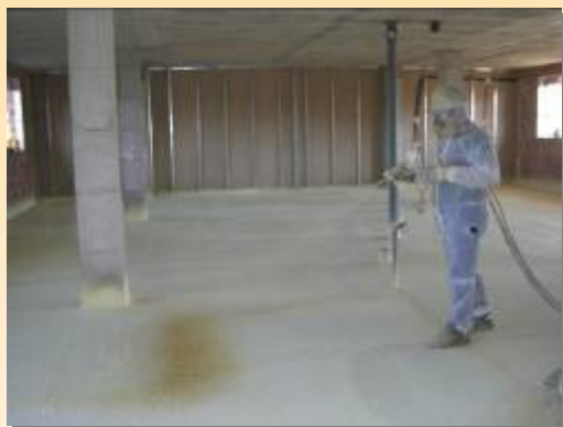
Capa continua de poliuretano proyectado en el suelo, antes del solado
