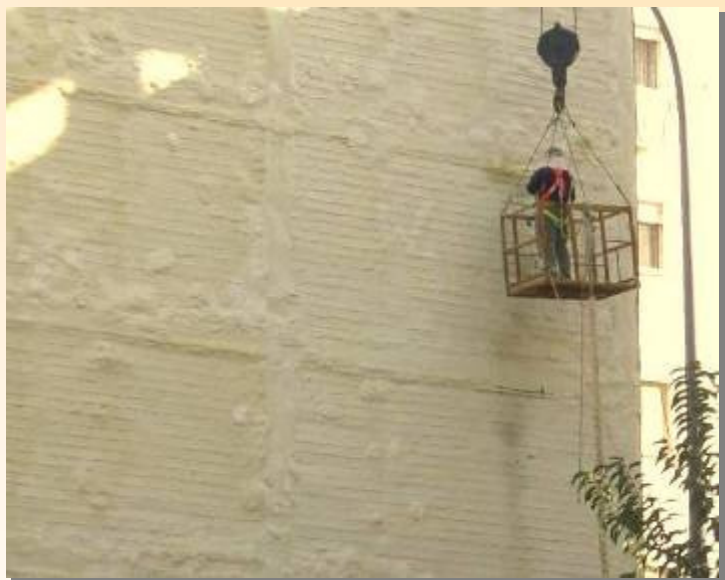
Una protección posterior de la espuma con una pintura o un elastómero prolongará la vida del aislamiento y sus prestaciones.
