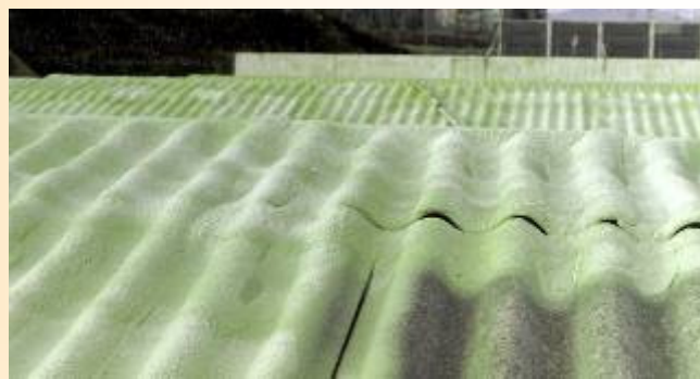
La proyección de poliuretano sella todas aquellas pequeñas fisuras o juntas que pudiese presentar la cubierta, reforzando la impermeabilidad
