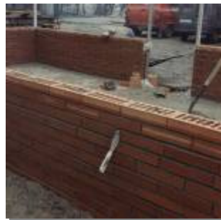
Detalle de las llagas verticales sin mortero.
