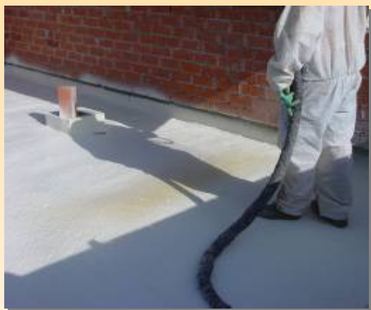
Cubierta transitable proyectada con espuma de poliuretano
