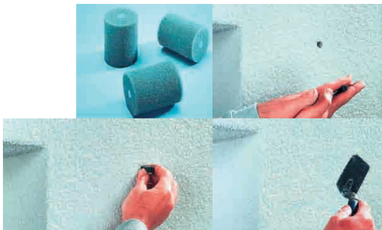
Figura 39. Detalle de una tapa de anclaje de andamio y su correcta instalación. Fuente: Guía IDAE: Sistemas de Aislamiento Térmico por el exterior (SATE) para la Rehabilitación de la Envoltura Térmica de los Edificios.
