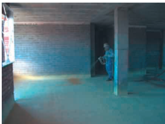
Foto 3. Proyección de poliuretano con una resistencia a compresión mayor de 200 kPa en el suelo de la planta baja. Fuente: ATEPA.
