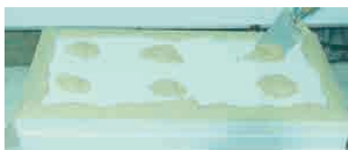
Pegado borde-punto en una plancha de EPS
