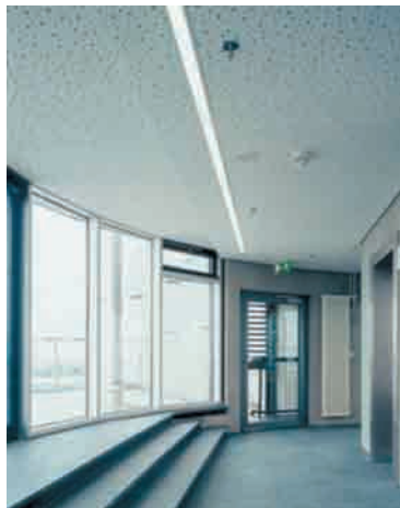
Figura 7. Techo con placa yeso laminado con perforación aleatoria 8/15/20. Fuente: Knauf.
