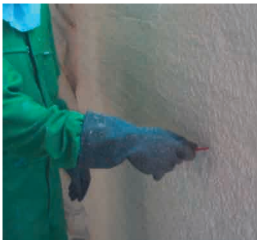
Foto 6. El ensayo de medición del espesor se realizará al menos cada 75 \text{ m}^2
