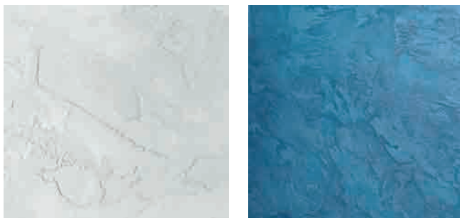
Figura 28. Texturas de acabado fino con efecto en un mismo color y acabado fino con efecto en dos colores de una misma gama. Fuente: Guía IDAE: Sistemas de Aislamiento Térmico por el exterior (SATE) para la Rehabilitación de la Envolvente Térmica de los Edificios.
