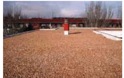
Foto 3: Cubierta inclinada. Fuente: ANAPE.
