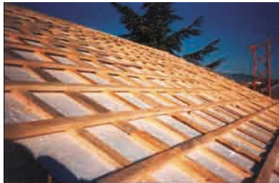
Foto 2: Cubierta plana. Fuente: ANAPE.
