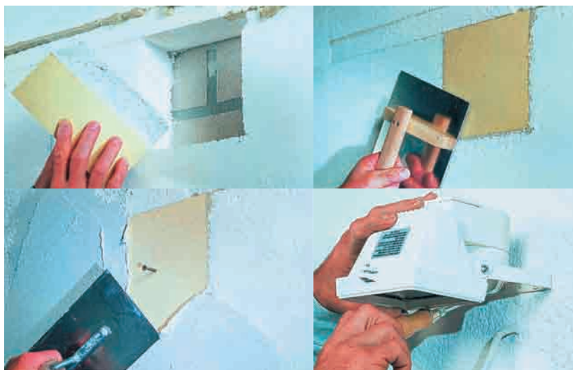
Figura 37. Instalación de un elemento de fijación para una carga pesada. Fuente: Guía IDAE: Sistemas de Aislamiento Térmico por el exterior (SATE) para la Rehabilitación de la Envoltura Térmica de los Edificios.
