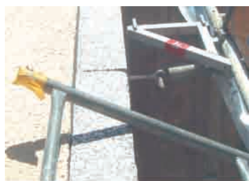
Figura 41. Detalle de la fijación del andamio a la fachada. Fuente: Guía IDAE: Sistemas de Aislamiento Térmico por el exterior (SATE) para la Rehabilitación de la Envolvente Térmica de los Edificios.
