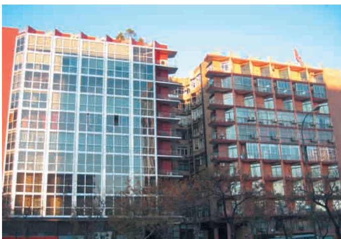
Foto 7. Rehabilitación de fachada con UVA de control solar. Fuente Propiedad del autor.
