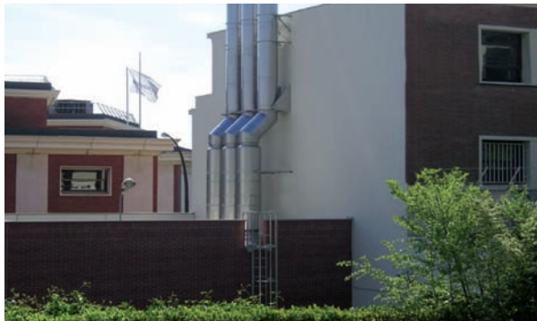
Fig. 94: Sistemas de salida de gases de acero inoxidable en instalaciones de calefacción que funcionan con motores de combustión
