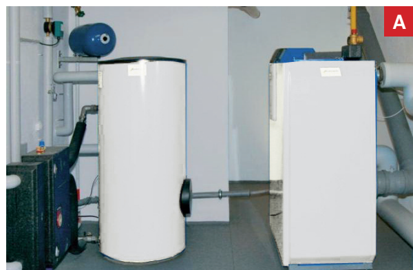
A Moderna caldera de condensación de gas/gasóleo
