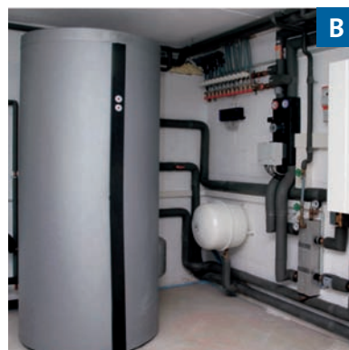
B Moderna caldera de condensación de gasóleo/gas
