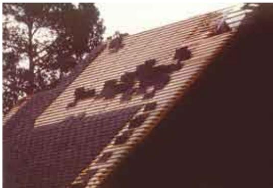
En caso de que la cubierta sea ventilada se debe colocar una estructura de madera que garantice la cámara de aire.
