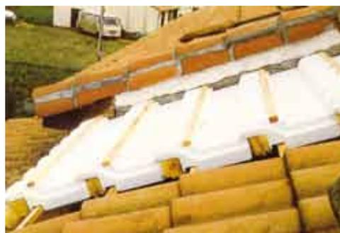
Las cubiertas planas pueden rehabilitarse térmicamente por el interior y por el exterior. Las cubiertas inclinadas pueden rehabilitarse térmicamente por el exterior y en caso de espacios bajo cubierta accesible, por el interior bajo el faldón o bien sobre forjado.
