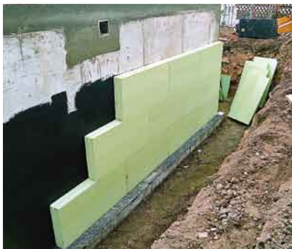
Ejemplo de aplicación en fachada exterior
