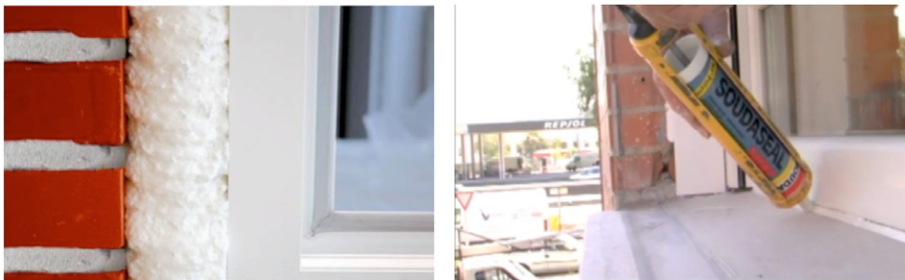
Figura 41. Instalación tradicional de ventanas
