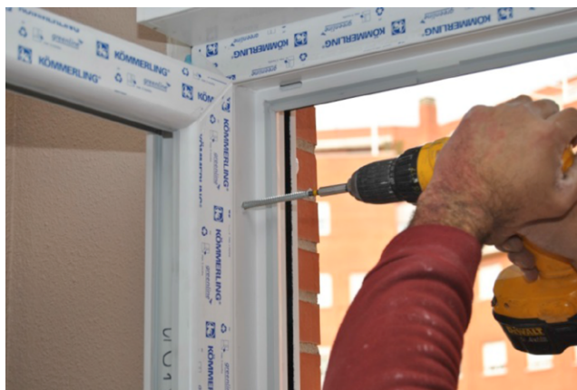
Figura 44. Fijación de la ventana al hueco
