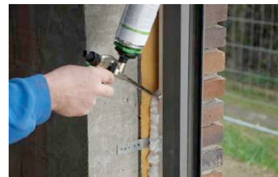
Figura 28. Sellado interior de la ventana
