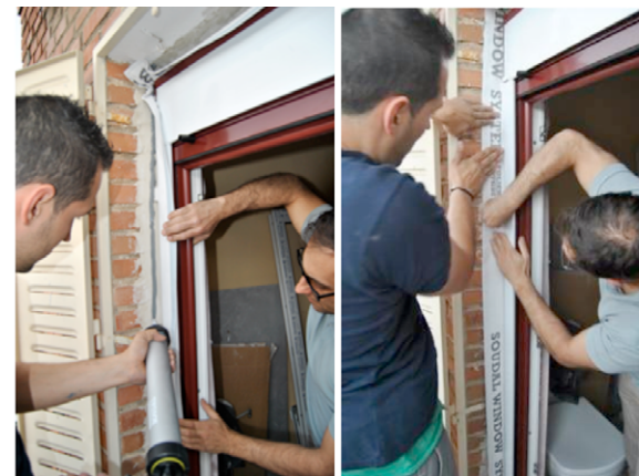
Figura 46. Fijación de las membranas
