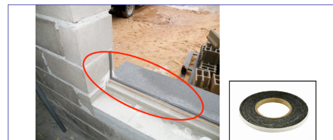
Figura 43. Bandas precomprimidas de PU auto-adhesivas
