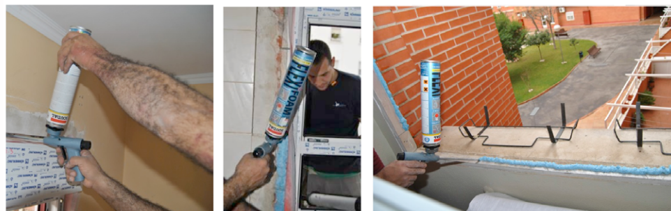
Figura 45. Aplicación de la espuma
