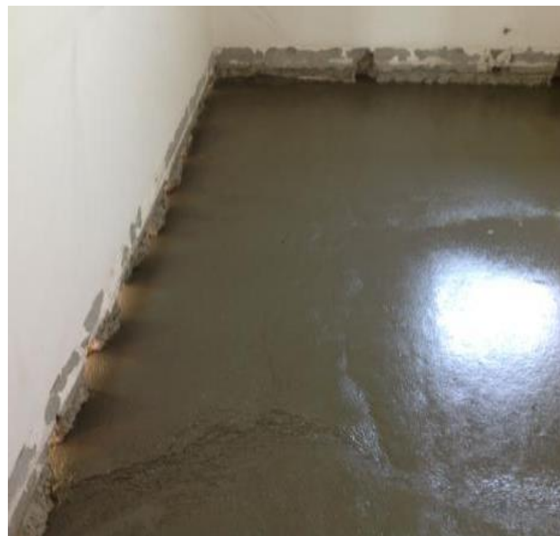
Vigilancia en el curado de PLANITOP HPC FLOOR
