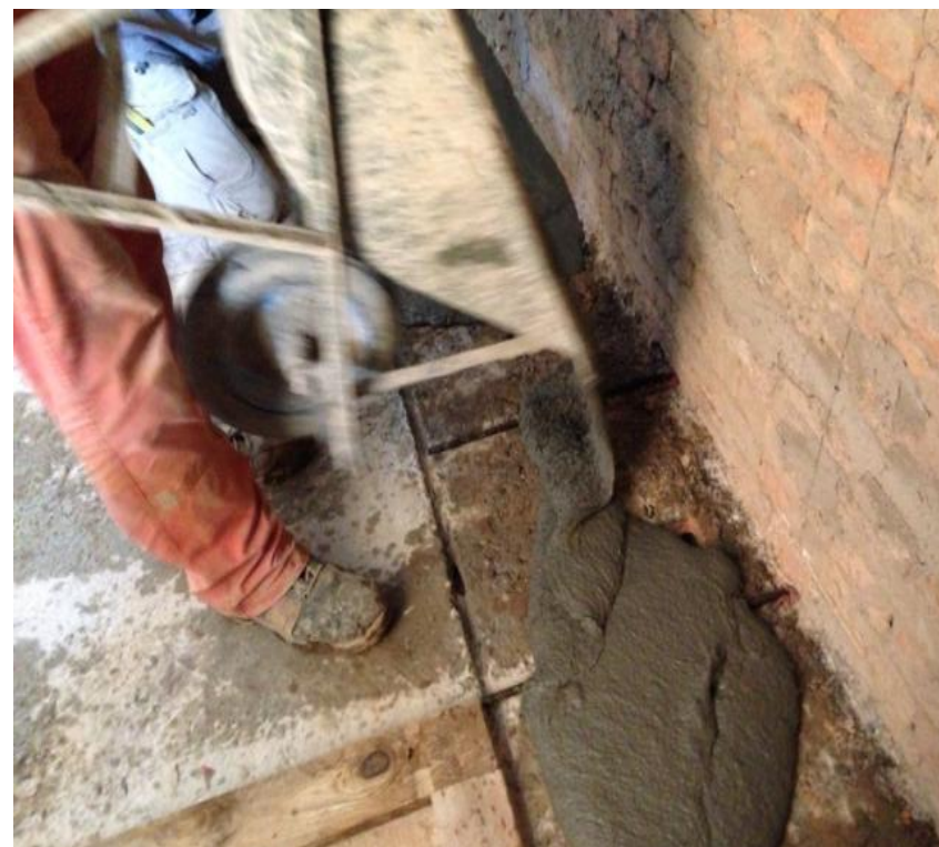
Vertido de PLANITOP HPC FLOOR
