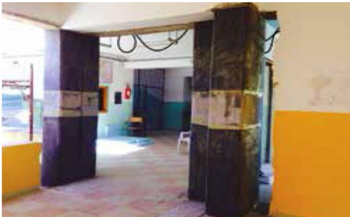
2 | Refuerzo a cortante de pilares con tejidos MapeWrap C Escuela primaria, Frazione Mirto - Crosia (CS)
