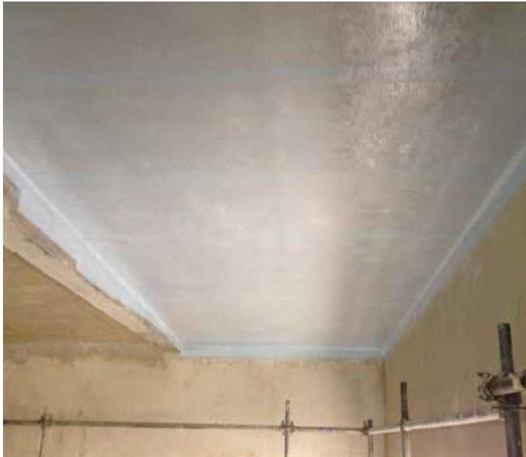
2 | Sistema anti-desprendimiento de elementos de los forjados mediante MapeWrap EQ System Escuela primaria Leonardo da Vinci en Pove del Grappa (VI)
