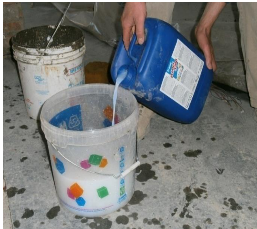
Consolidación de las áreas de intervención, con PRIMER 3296
