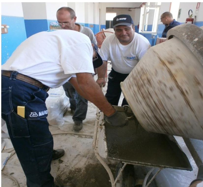
Preparación del mortero con una hormigonera
